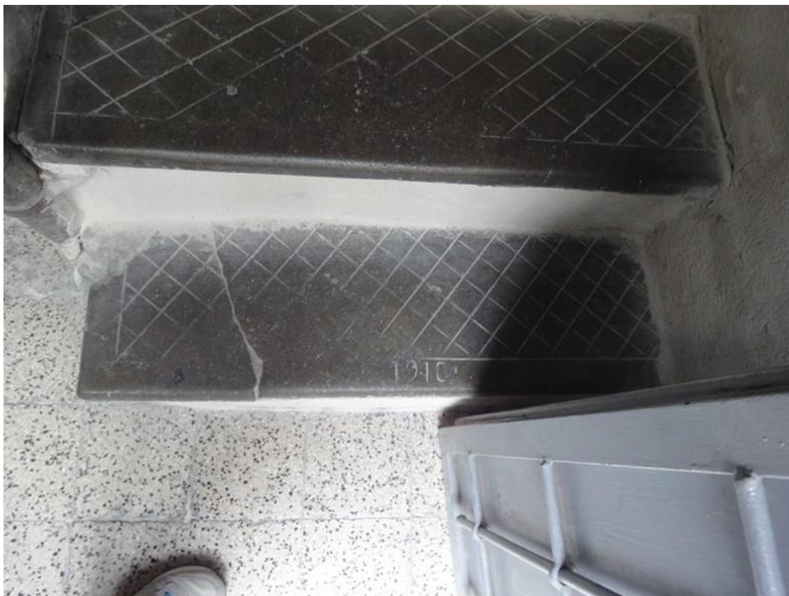
Foto 3- accesso al fabbricato di Via Matteo Renato Imbriani 207
