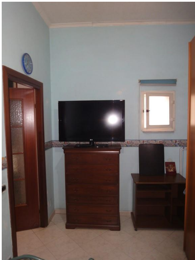
Foto 14- immobile al piano 3° di Via Matteo Renato Imbriani 207: LETTO (porzione del vano N. 1 catastale), visibile sulla sinistra il tramezzo realizzato e di fronte la finestra realizzata su Via Imbriani
