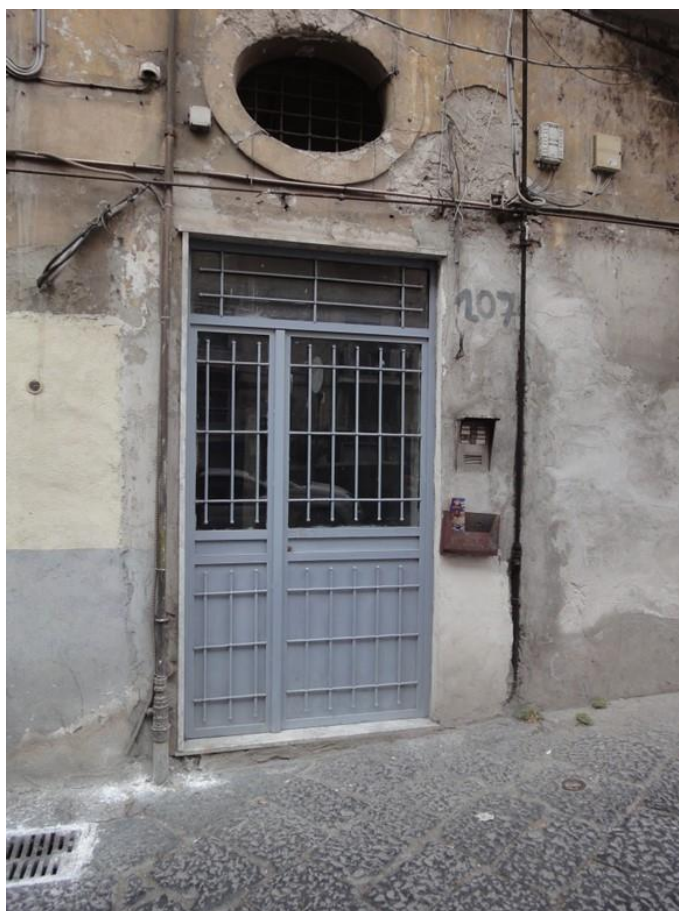
Foto 2- accesso al fabbricato di Via Matteo Renato Imbriani 207
