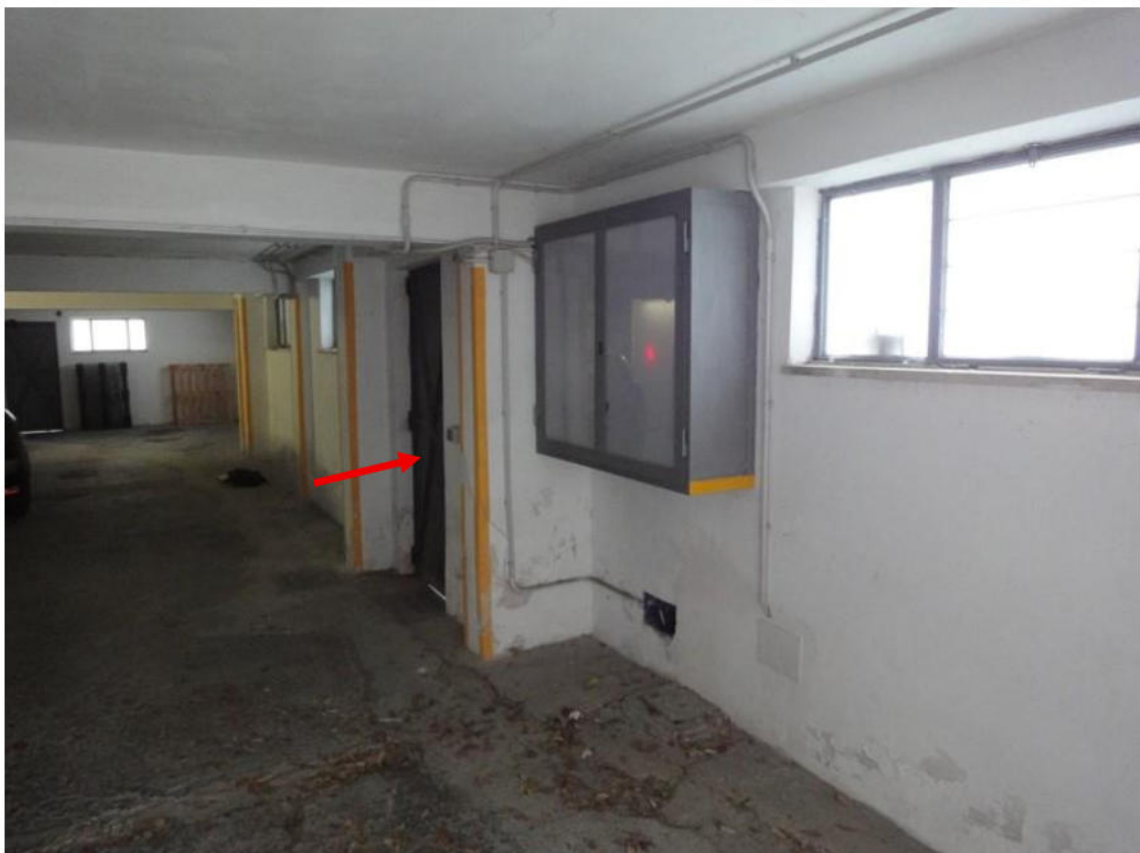
Foto 6- - garage comune (SUB 1) oggetto di stima, sulla destra la porta di accesso alla abitazione di proprietà del debitore istante (SUB 2) oggetto di procedura esecutiva RGE 42/2024
