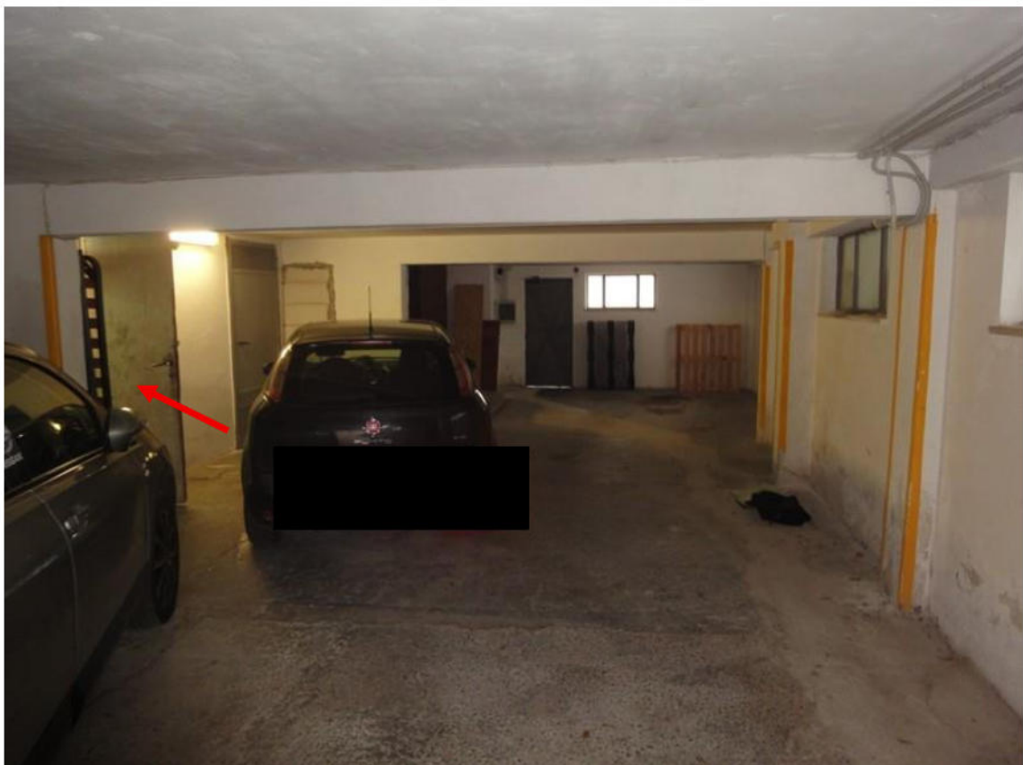
Foto 4- garage comune (SUB 1) oggetto di stima, sulla sinistra la porta di accesso alla cantinola di proprietà del debitore istante (SUB 2) oggetto di procedura esecutiva RGE 42/2024
