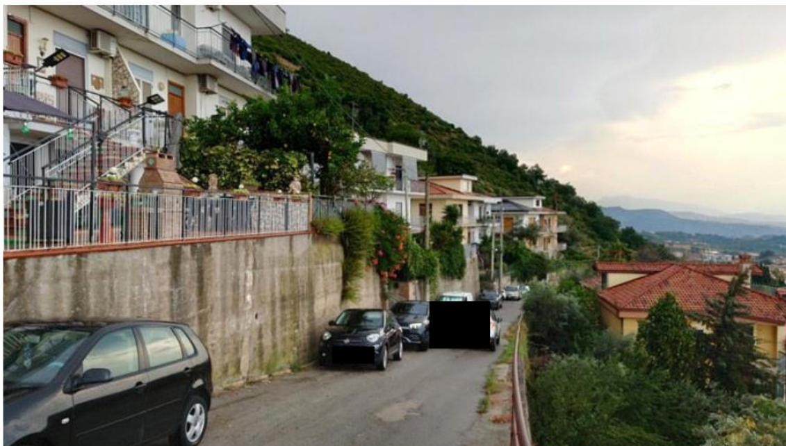
Foto 1- accesso al fabbricato in cui ricade l'immobile (SUB 1) oggetto di stima dalla Via Sant'Angelo di Ogliara
