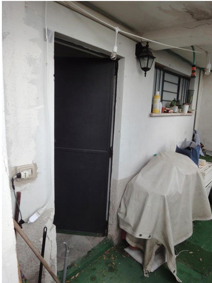
Foto 7- porta di accesso che dalla abitazione di proprietà del debitore istante (SUB 2) oggetto di procedura esecutiva RGE 42/2024 conduce direttamente al garage comune (SUB 1) oggetto di liquidazione familiare
