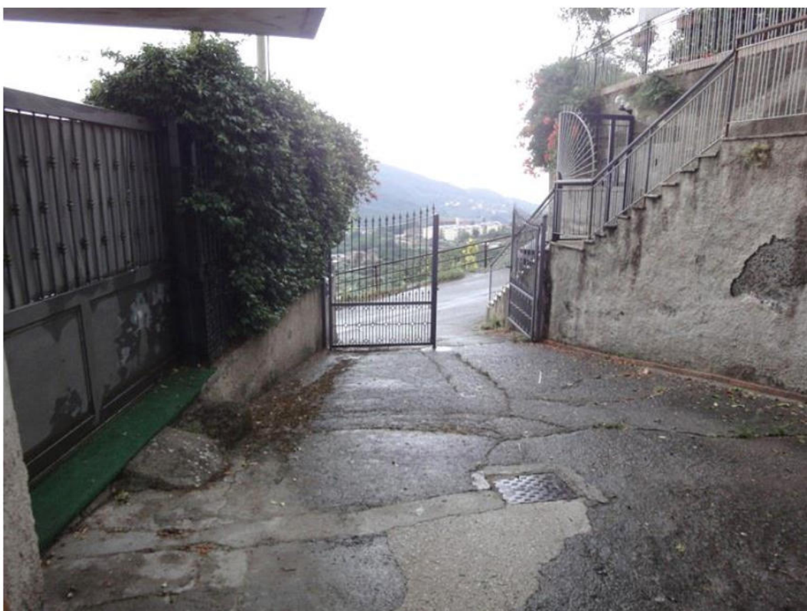
Foto 2- cancello carrabile che dalla Via Sant'Angelo di Ogliara conduce al garage comune (SUB 1) oggetto di stima
