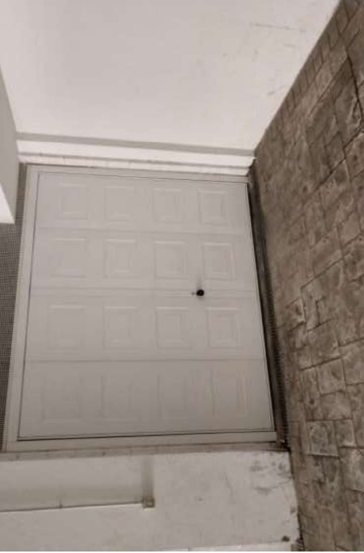
Garage sub. 33 al Piano S1 del blocco A
