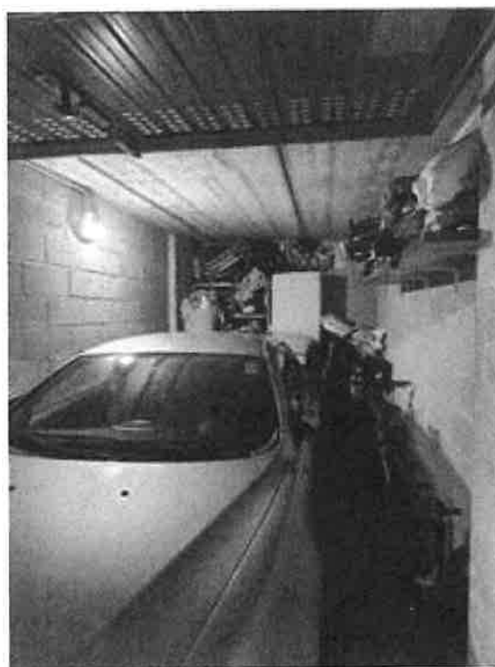
Fotografia D.12 - Vista interna garage
