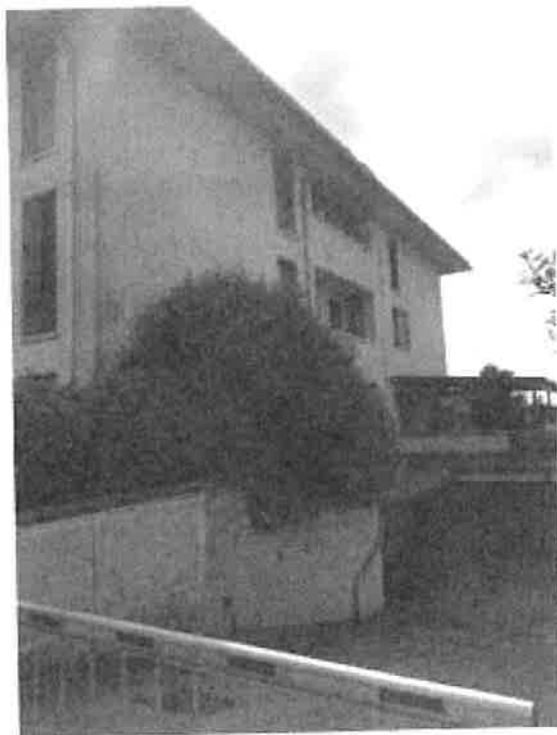
Fotografia D.2 - Vista esterna rampa ingresso interrato
