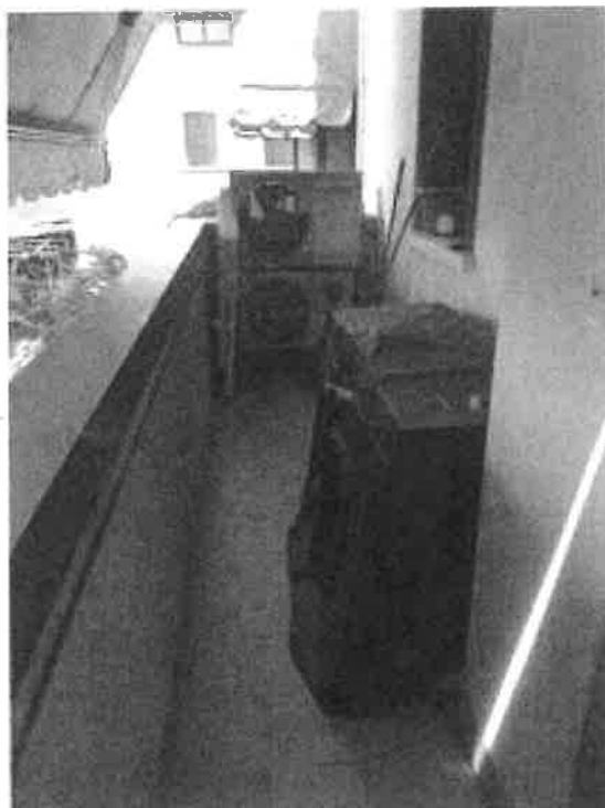
Fotografia D.11 - Vista esterna terrazzo
