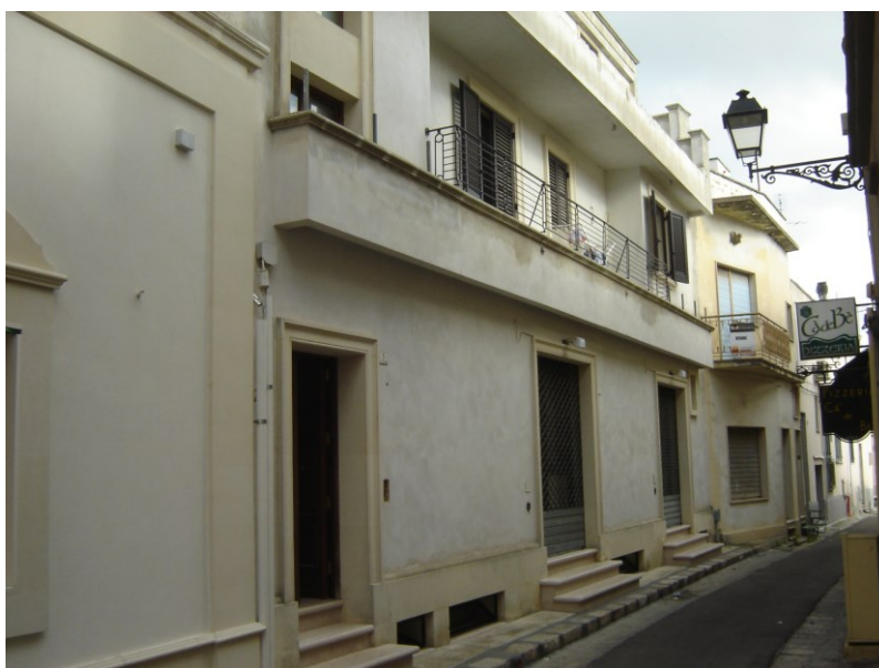
FOTO 2 (ingressi del locale)
