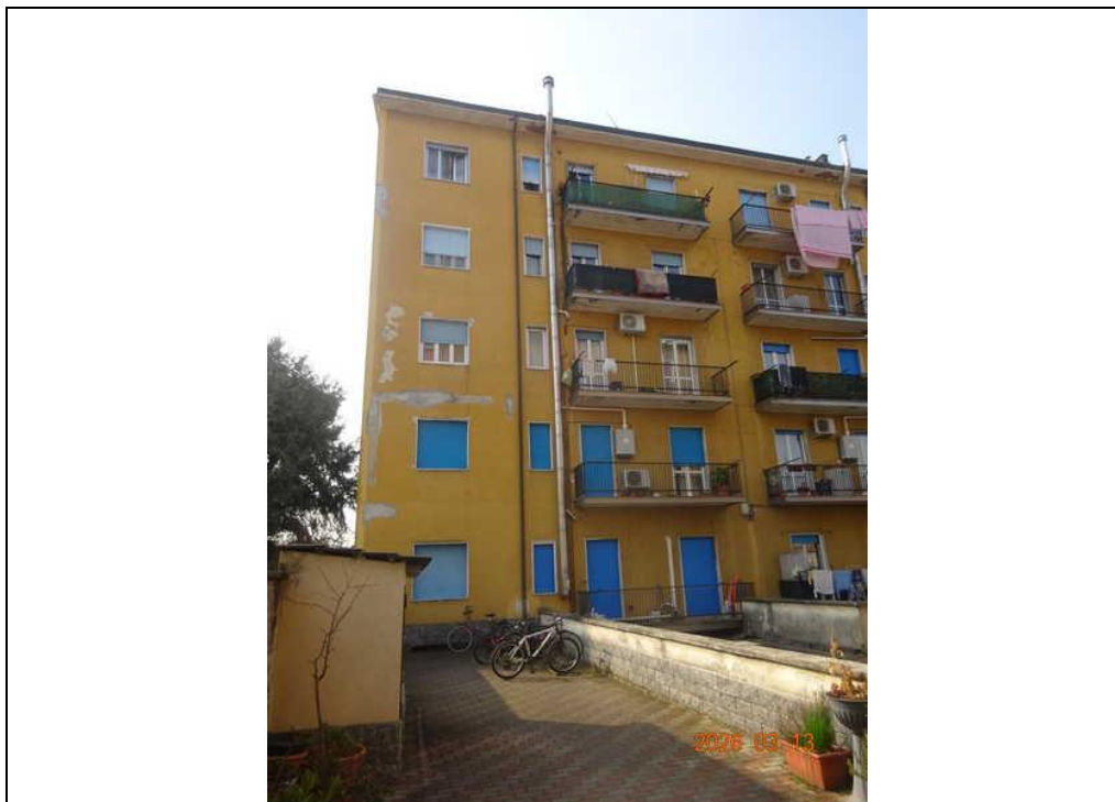
Vista del fabbricato dal cortile interno (retro)
