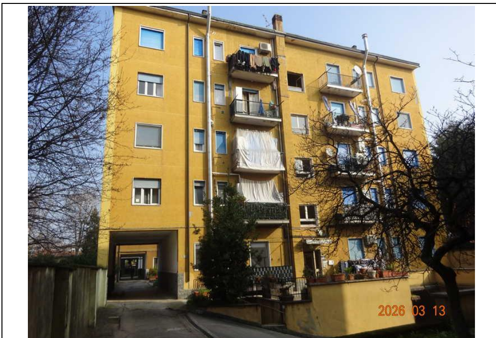
Vista ingresso fabbricato dal cortile interno (lato ingresso fabbricato)
