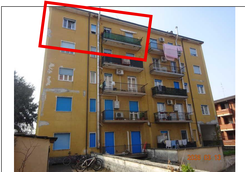
Vista del fabbricato dal cortile interno (retro)
