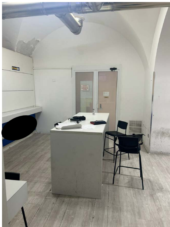
Figura 5: vano piano terra del fabbricato sito nel comune di Niscemi - foglio 89 part. 592 sub 18.
