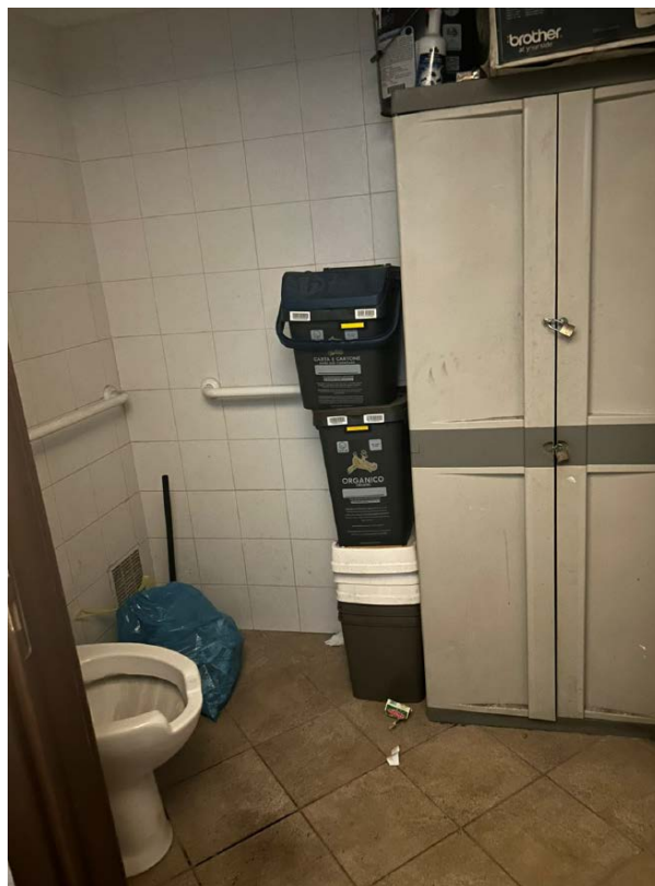
Figura 8: wc piano terra del fabbricato sito nel comune di Niscemi - foglio 89 part. 592 sub 18.
