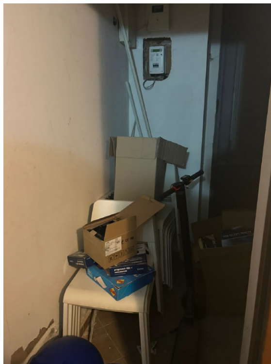
Figura 6: ripostiglio piano terra del fabbricato sito nel comune di Niscemi - foglio 89 part. 592 sub 18.
