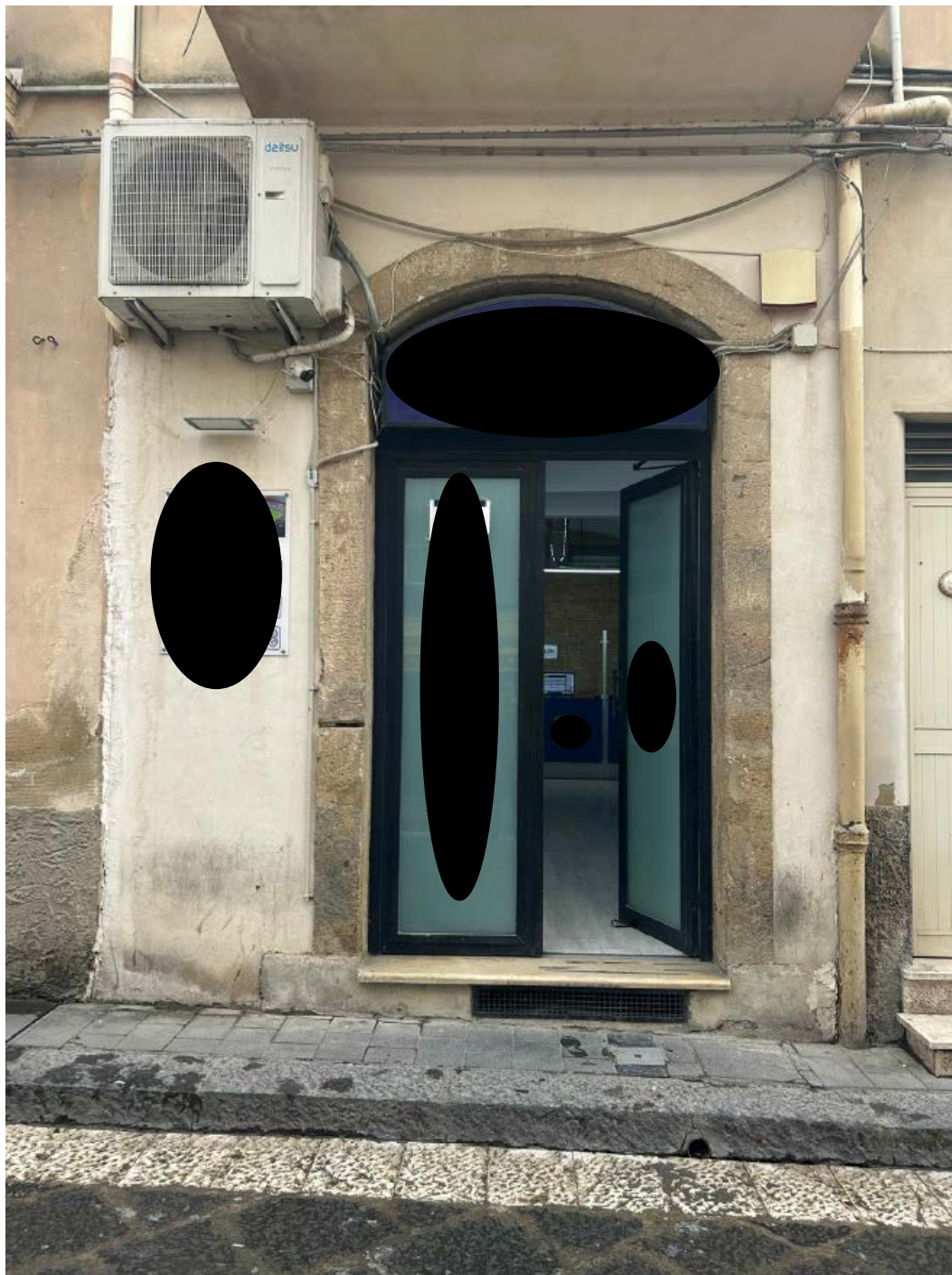
Figura 1: Prospetto fabbricato lato NORD via IV Novembre sito nel comune di Niscemi - foglio 89 part. 592 sub 18.
