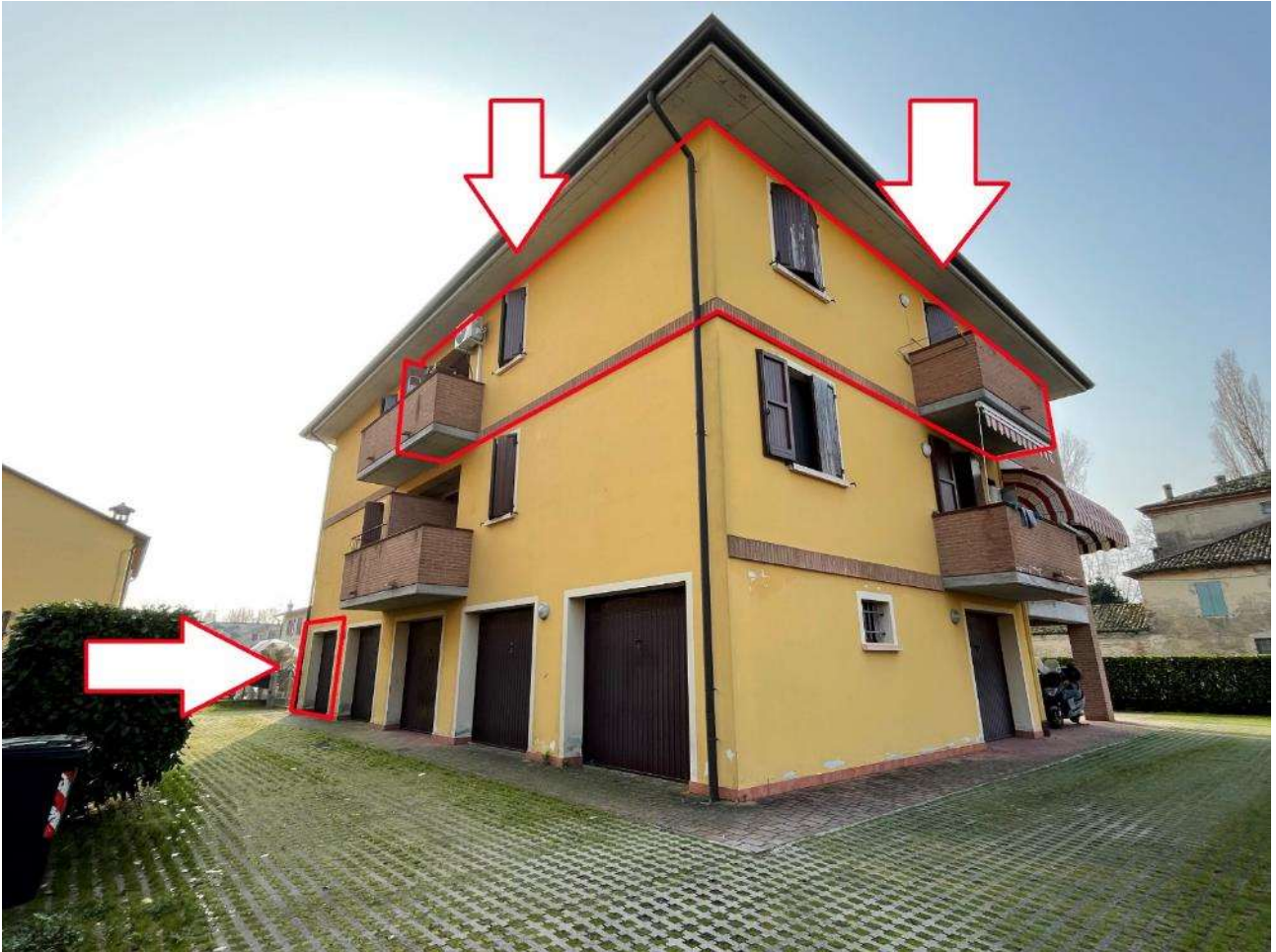
foto n. 1: vista lato nord-ovest del fabbricato che ricomprende le uu.ii. staggite
