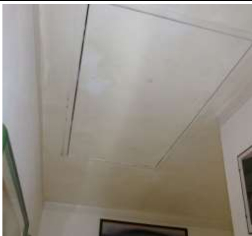
Botola al 1°P per accedere al sottotetto
