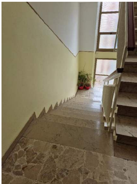
Figura 3: vano scala comune.
