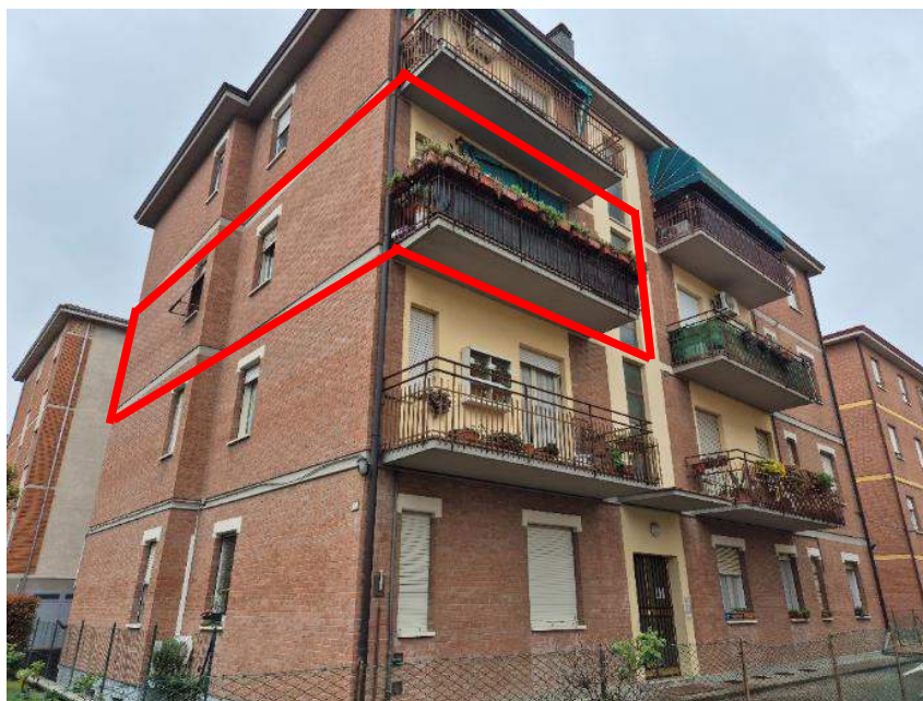
Figura 2: vista del prospetto principale del fabbricato
