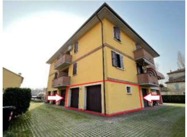
foto n. 2: vista lato nord-ovest del fabbricato che ricomprende le uu.ii. staggite
