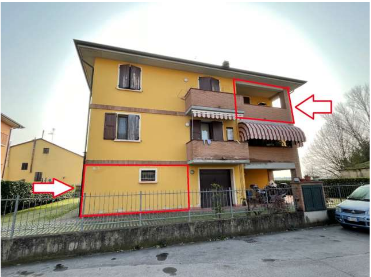
foto n. 3: vista lato ovest del fabbricato che ricomprende le uu.ii. staggite
