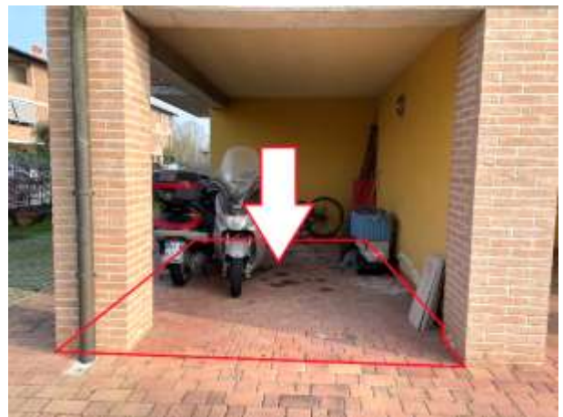
foto n. 3: vista lato sud del posto auto coperto
