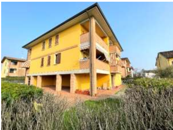
foto n. 2: vista lato sud-est del fabbricato che ricomprende le uu.ii. staggite
