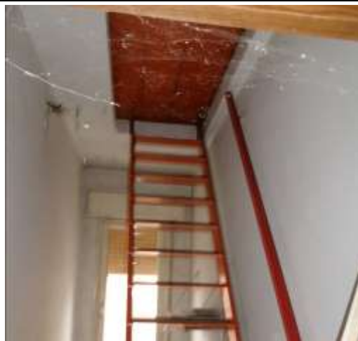
Botola per soffitta
