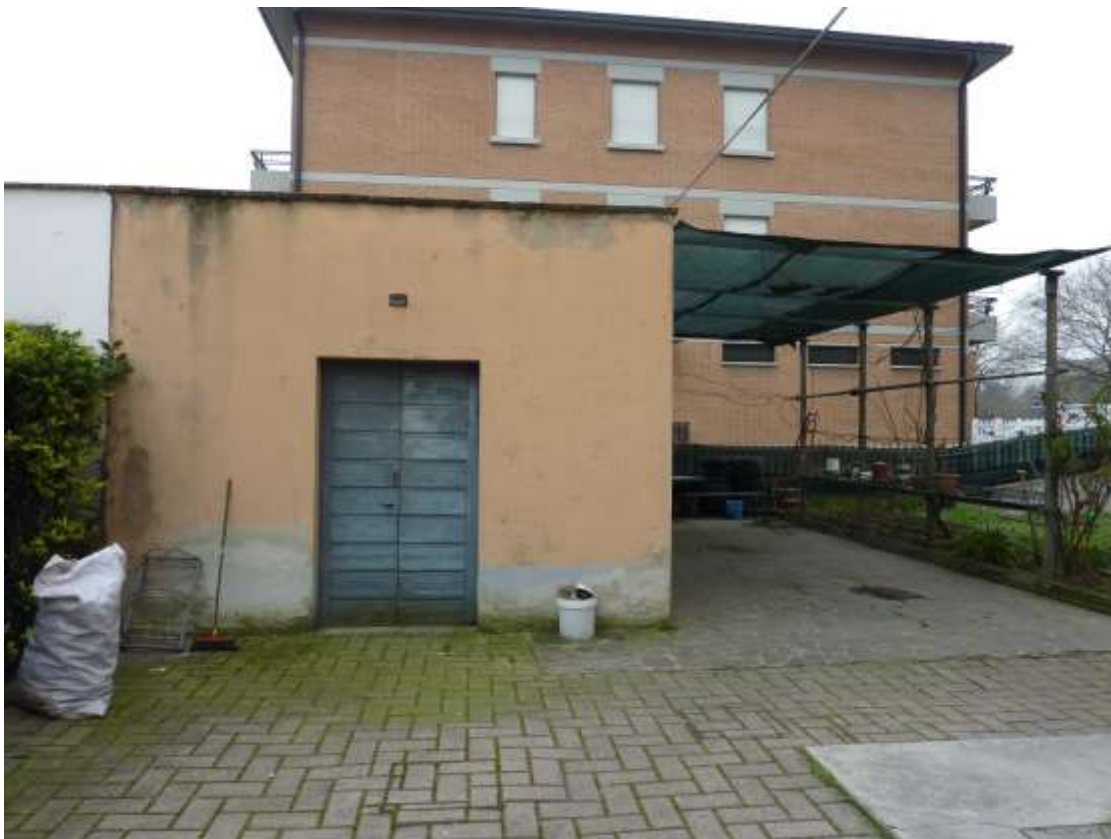
04b – Vista su particolare fabbricato comune "Lavanderia) e area cortiliva Mappale 18
