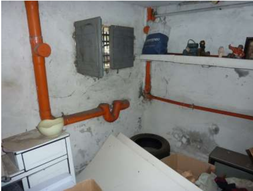
13b – Vista su Cantina angolo Nord-Est
