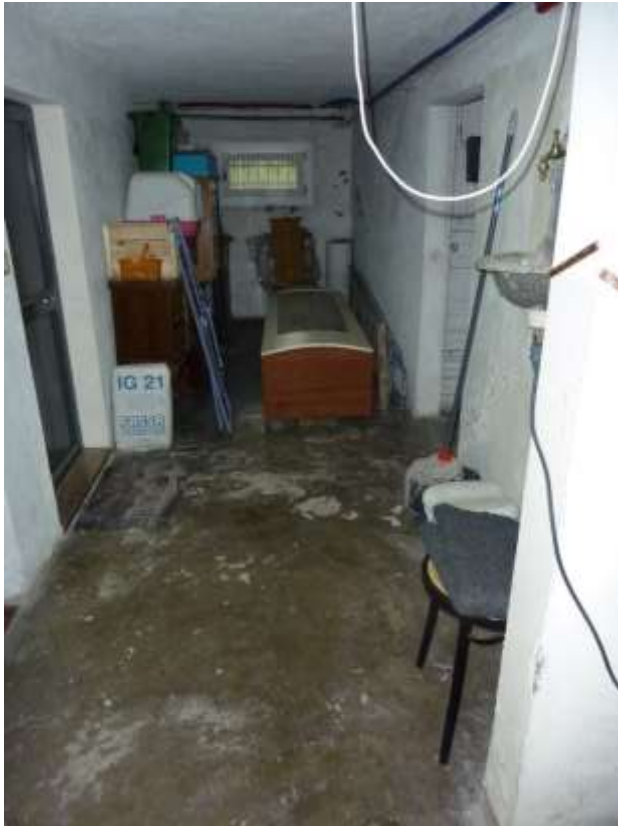
12 – Vista su Corridoio di accesso alle cantine poste al Piano Seminterrato
