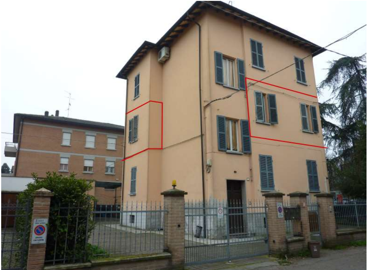
01 – Vista lato Nord-Est da Via Spalato n° 1
