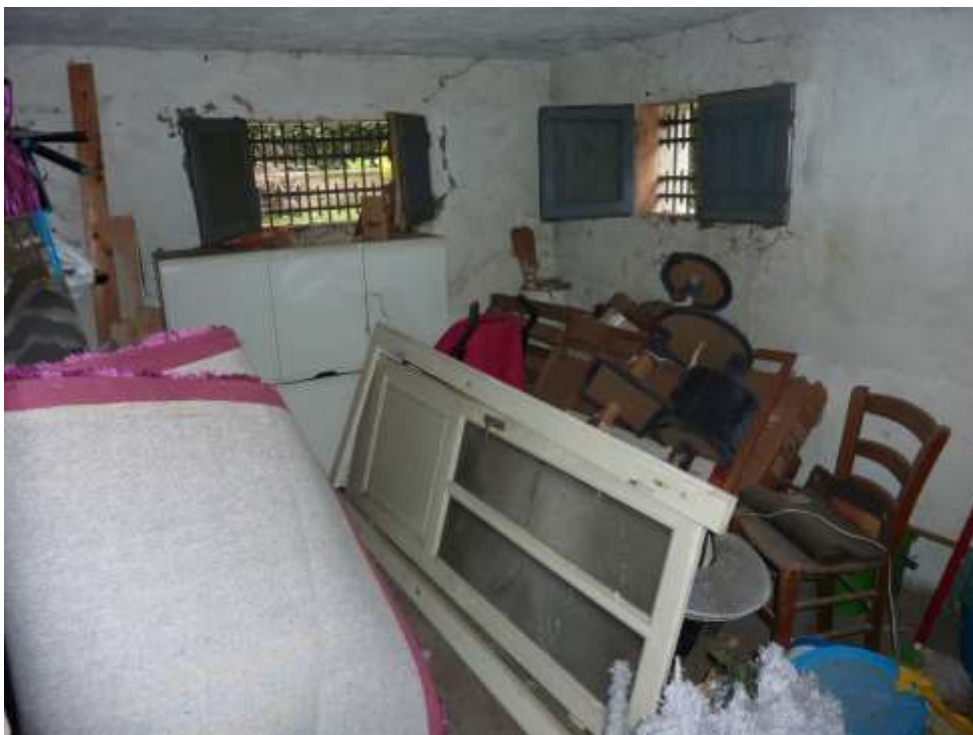
13 – Vista su Cantina angolo Nord-Ovest
