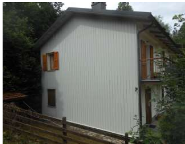
Esterno 2 (lato Sud-Est)
