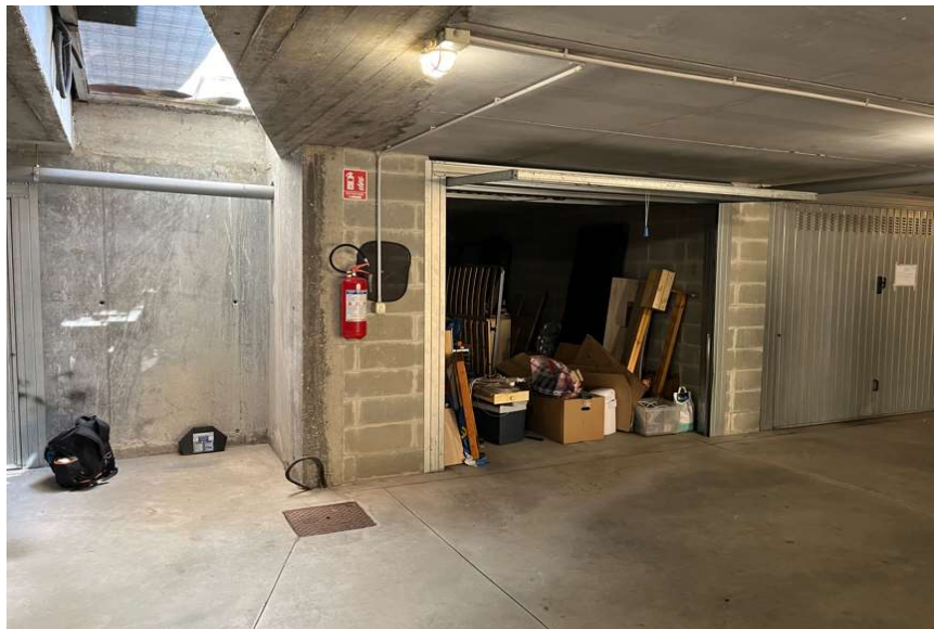
10 - vista vano autorimessa da corsello comune di manovra
