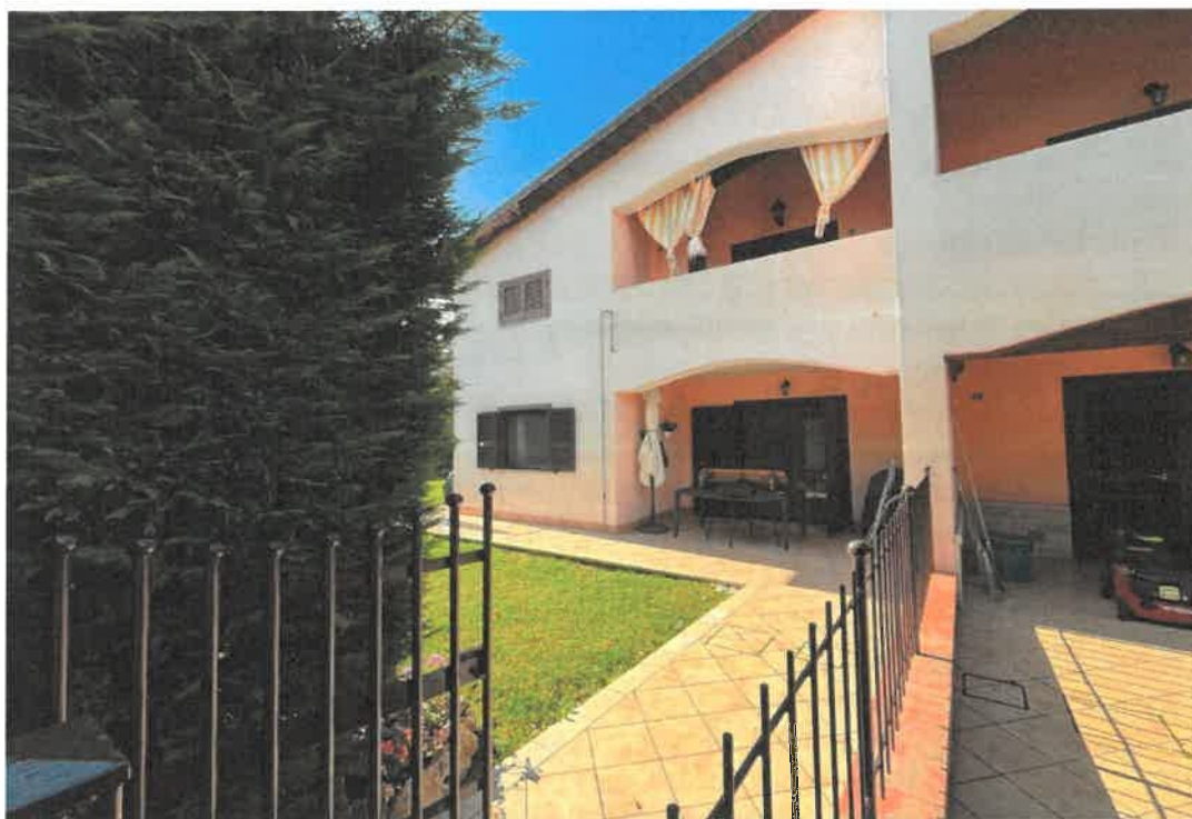
Figura 1 vista lato ingresso
