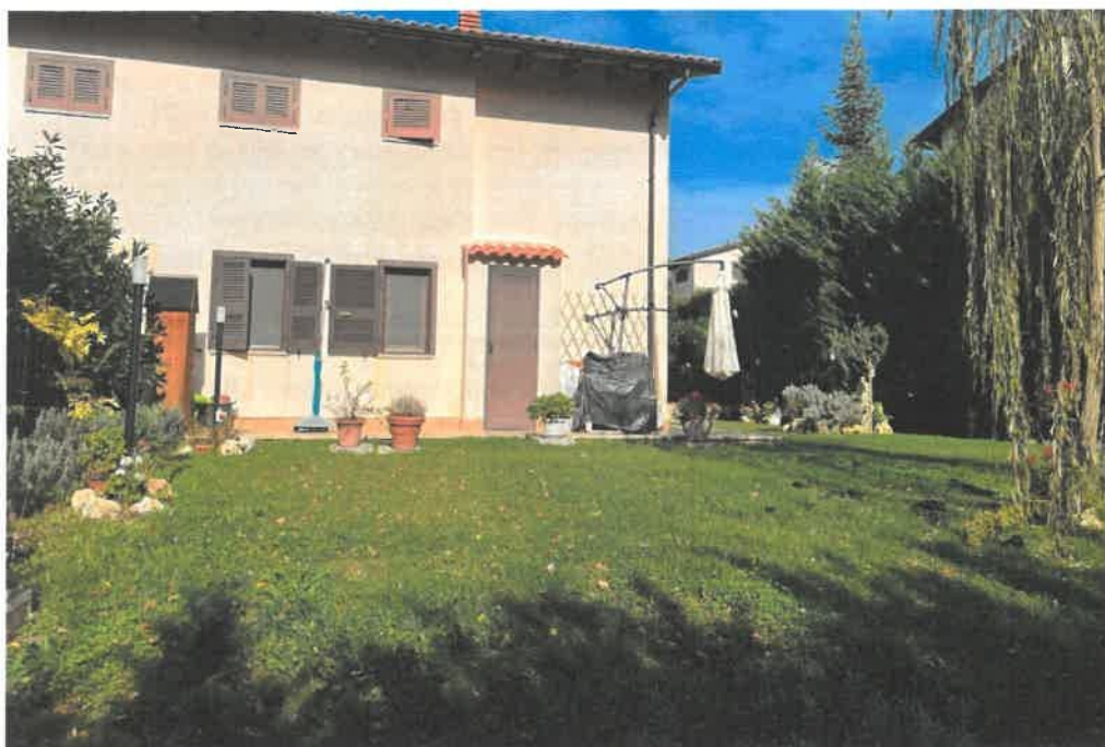
Figura 3 -Vista esterna con giardino
