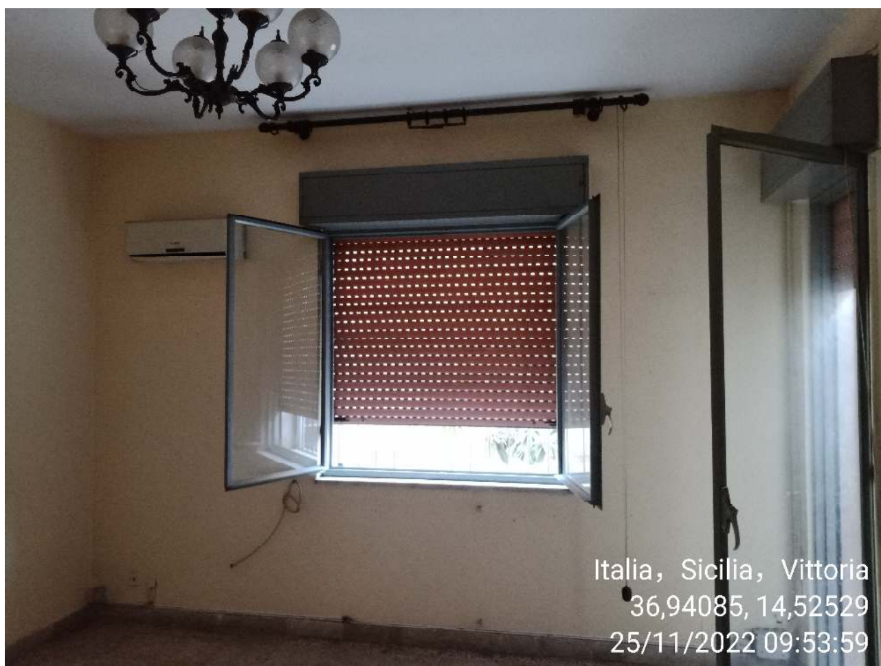
Figura 9 – camera da letto particolare infissi
