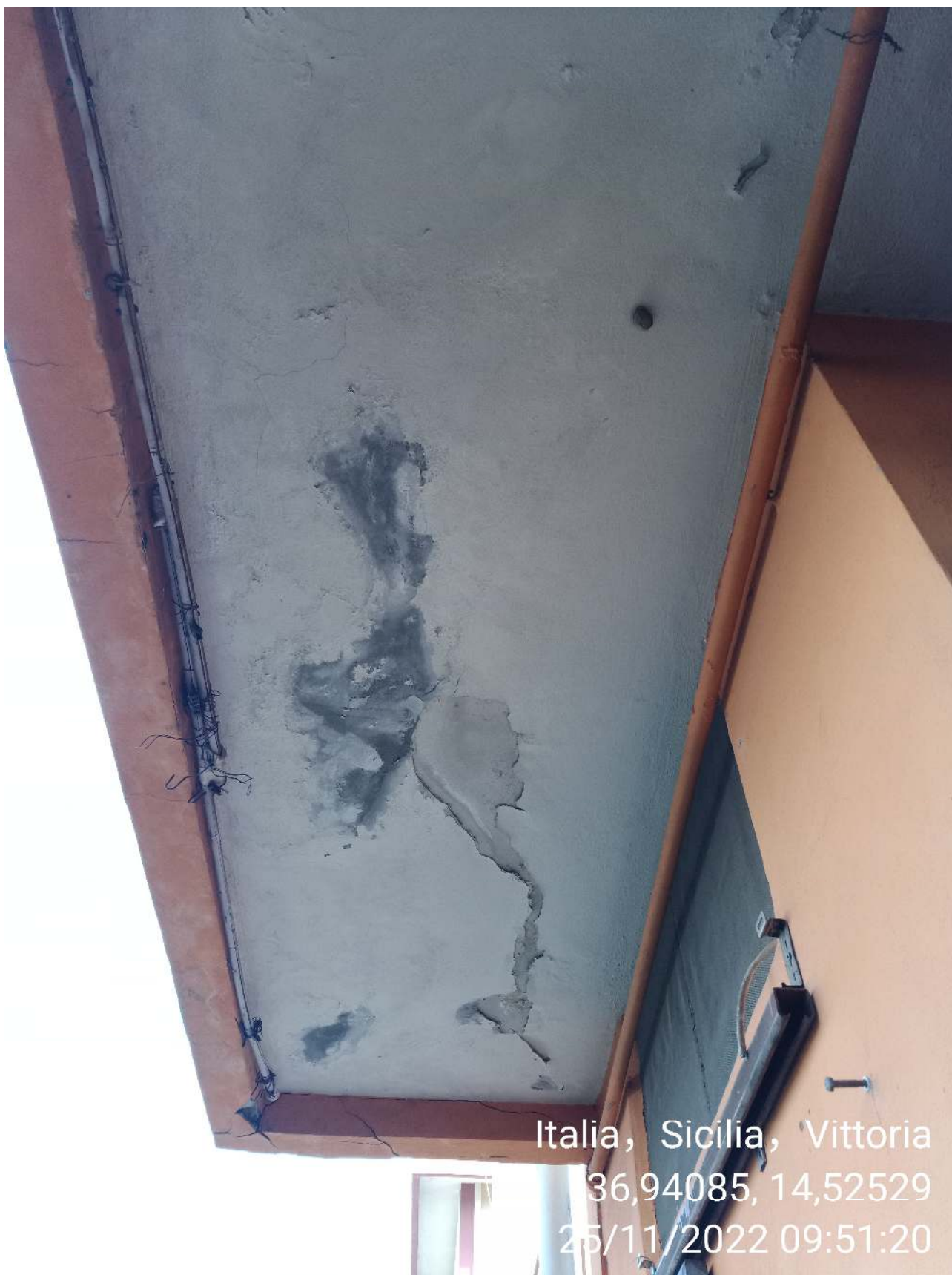
Figura 3 – Individuazione del degrado delle verande coperte e pensiline
