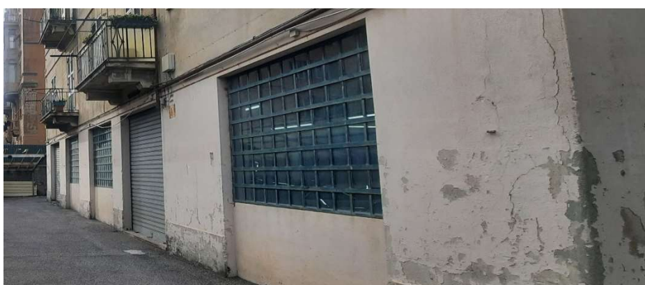
Foto 3 - Vista esterna lato est
