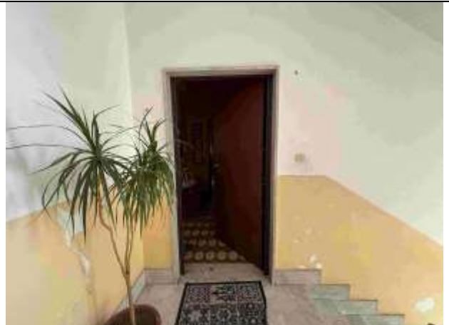
Vista portoncino di ingresso piano secondo
