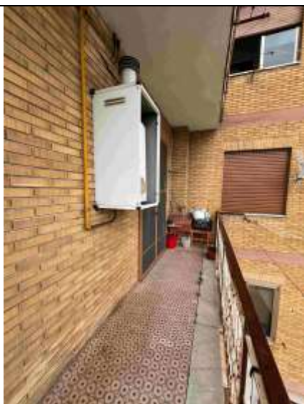
Balcone su cortile interno
