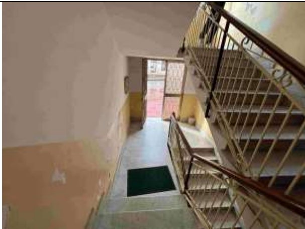
Vista vano scala
