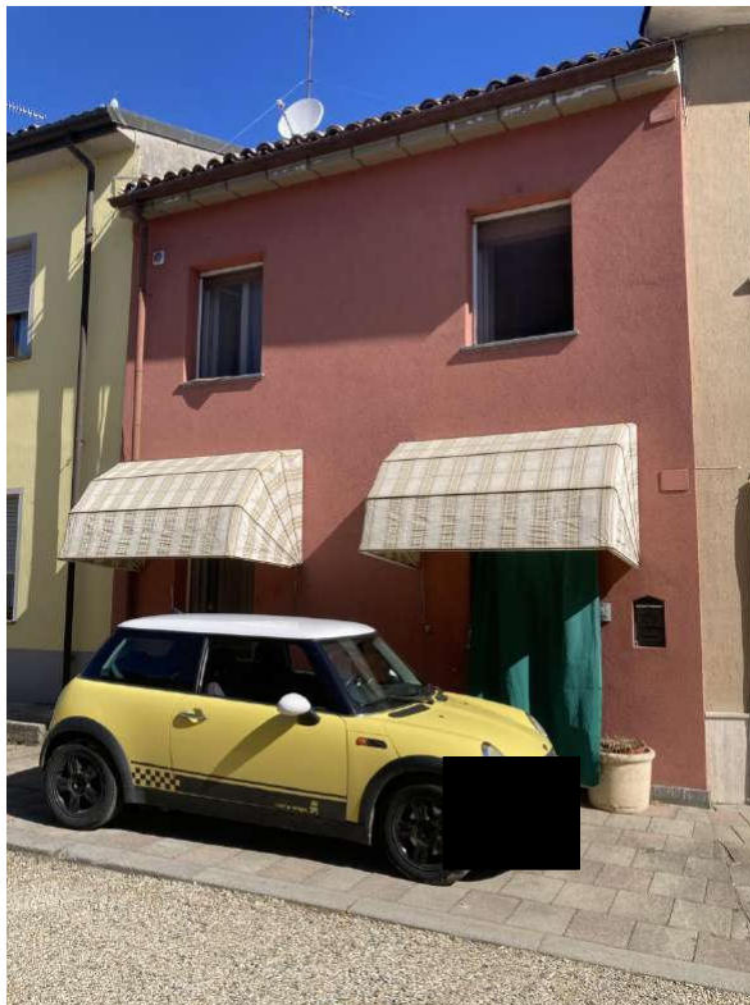
02 Prospetto esterno edificio.jpeg
