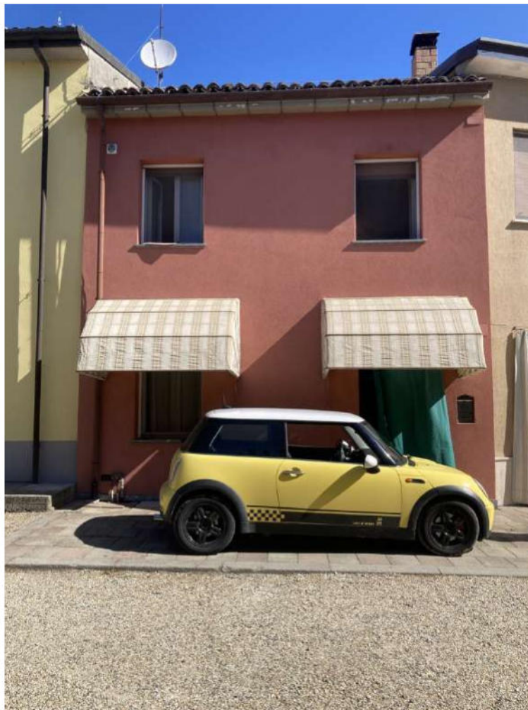
03 Prospetto esterno edificio.jpeg
