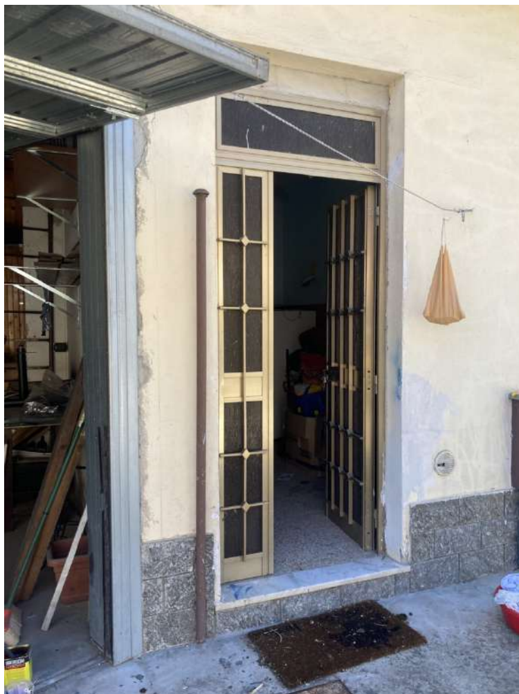
45 Accesso lavatoio da strada.jpeg
