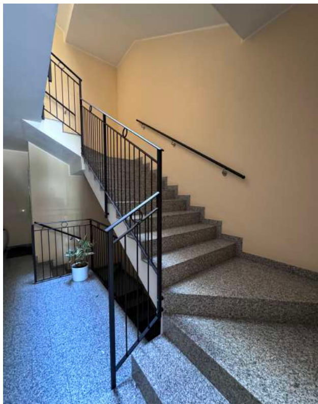
FOTO 1 - Vano scala condominiale
