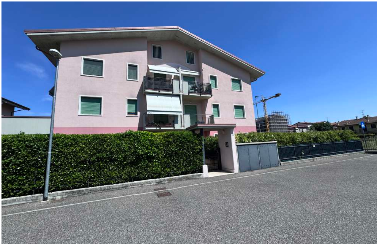
FOTO 1 - Fronte ovest via Buzzati
