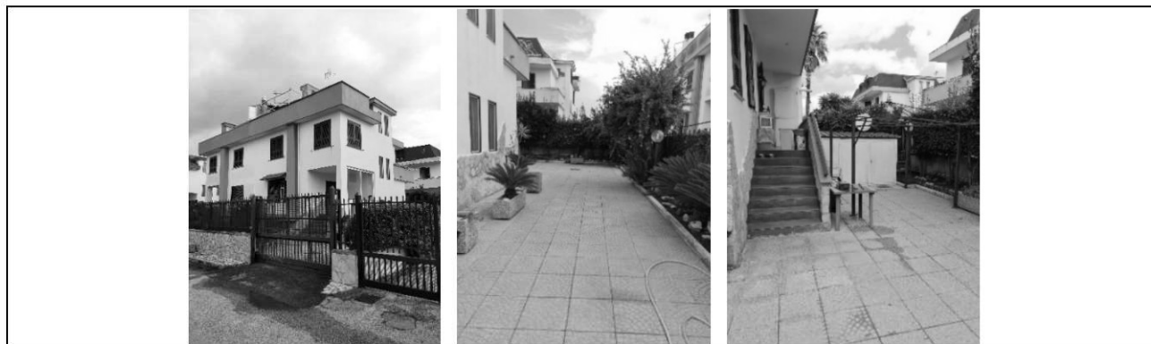
Foto 1/2/3 – Vista accesso pedonale e carrabile – vista cortile interno – vista cortile posteriore
