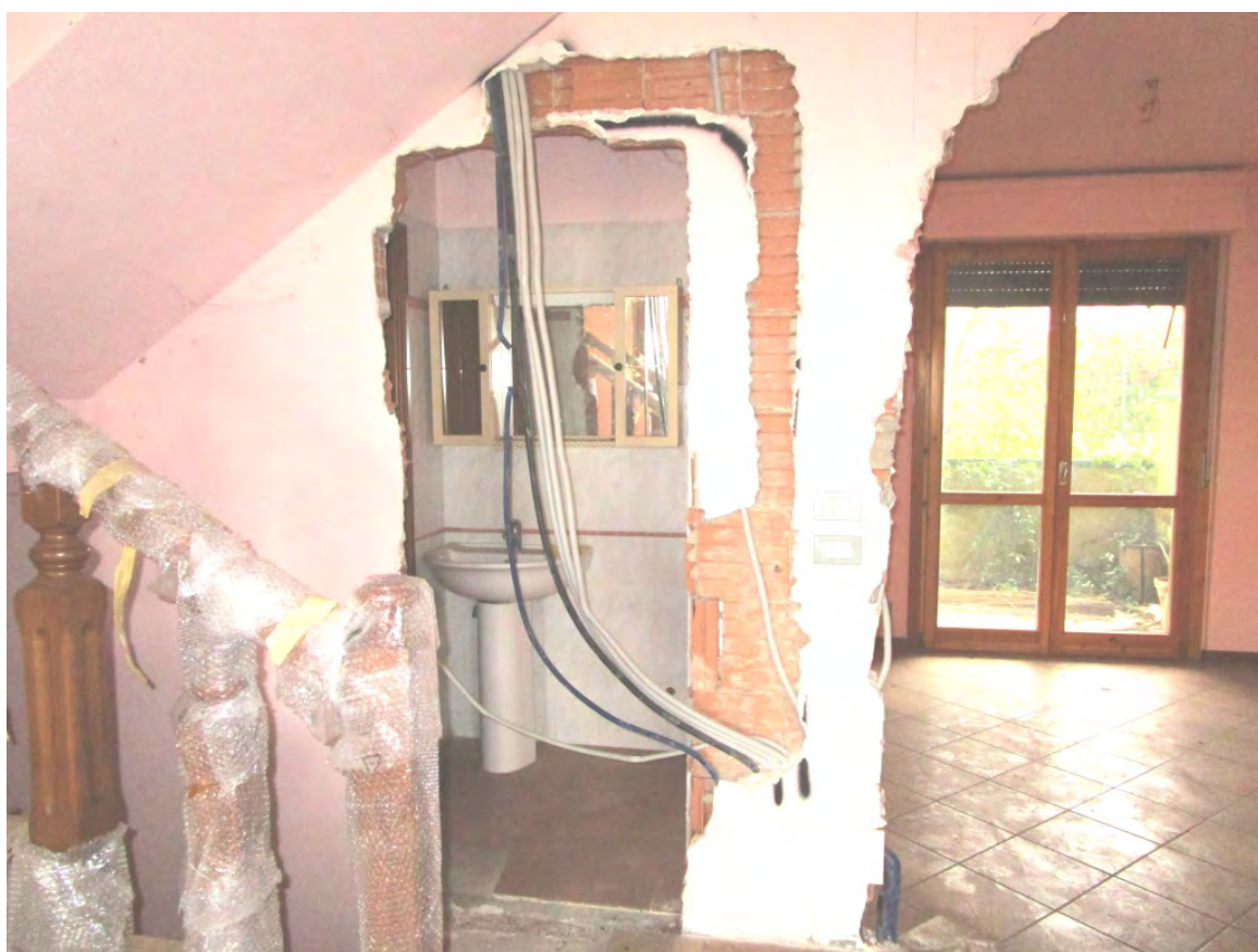
Apertura creata tra bagno e vano scala P
