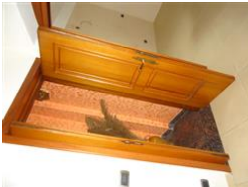
porta d'ingresso piano secondo
