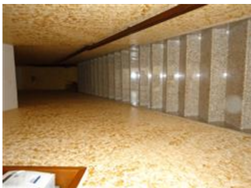
Foto n.3 della scala interna di accesso al piano primo
