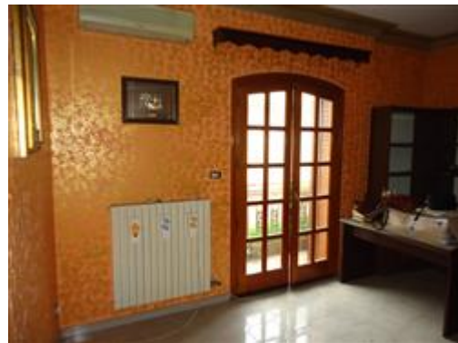
finestra esterna piano primo
