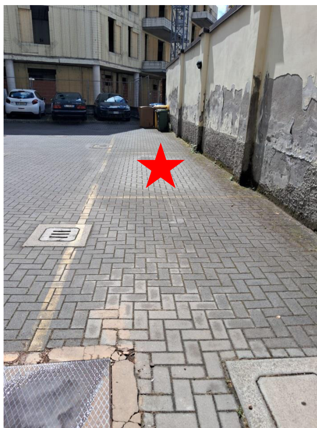
POSTO AUTO SCOPERTO IN CORTILE CONDOMINIALE
