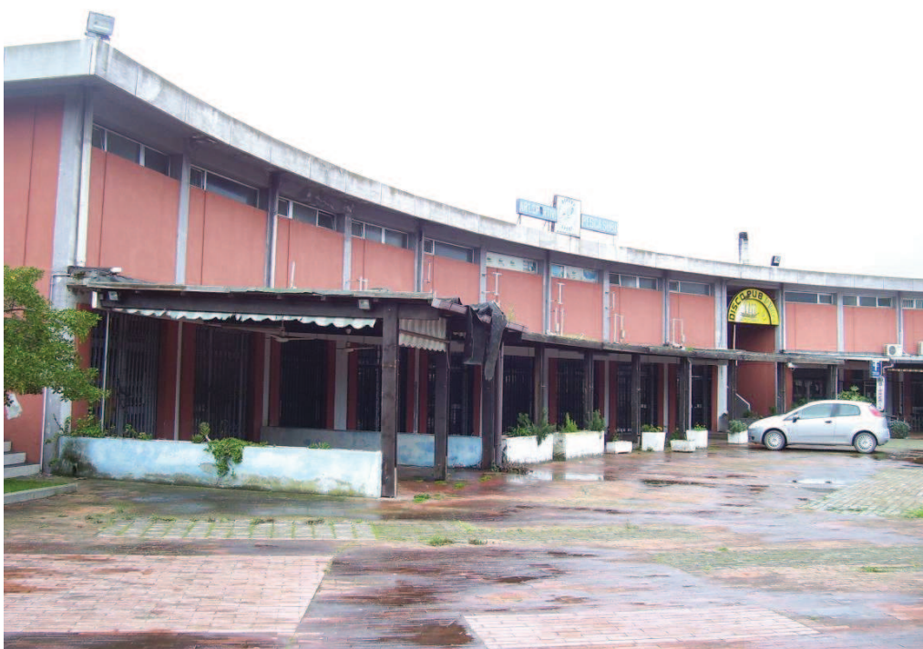
Foto 4 Porticato in legno Centro commerciale
