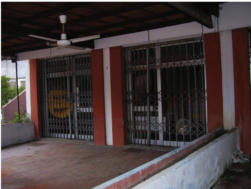
Foto 3 Serrande accesso sub 75
