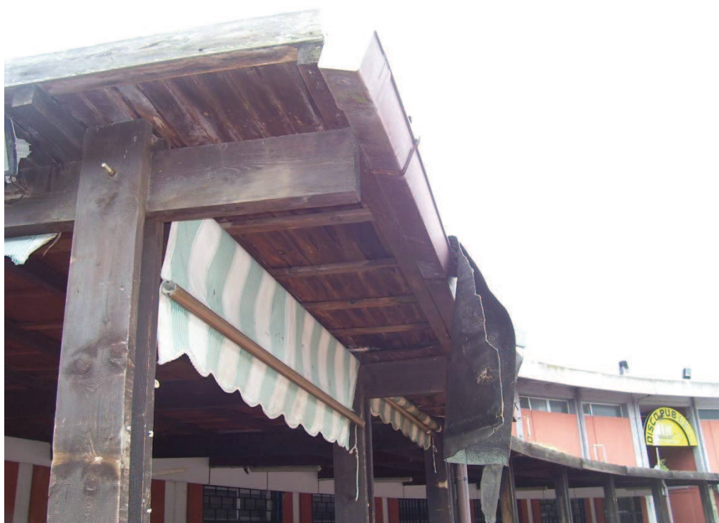
Foto 2 Particolare del porticato in legno
