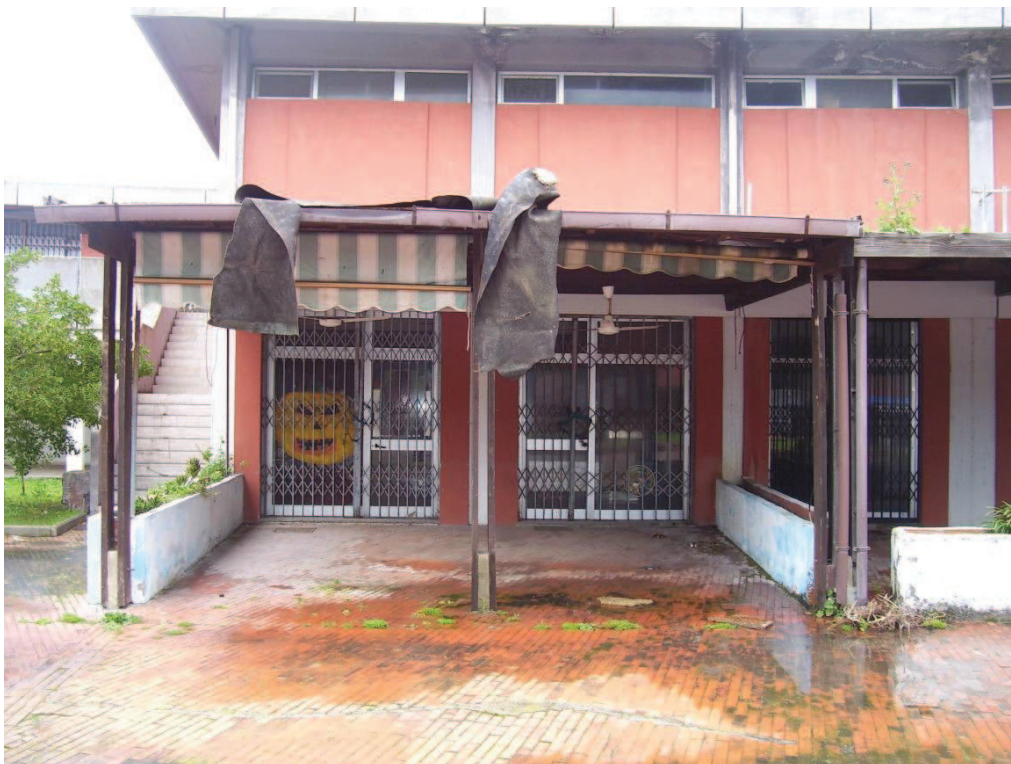
Foto 1 Ingresso locale sub 75
