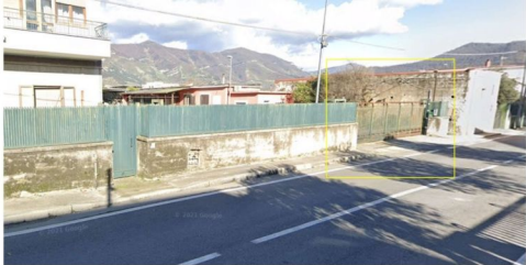
Vista dell'accesso carrabile al fabbricato P.lla 1549, in giallo , e delle aree pertinenziali esterne, comuni anche alle altre unità immobiliari.
