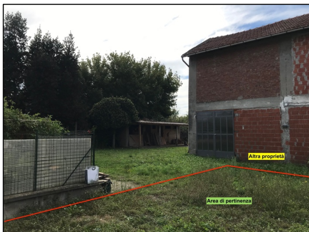
Particolare area di pertinenza Sud-Est
