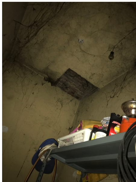
Botola di accesso al tetto
