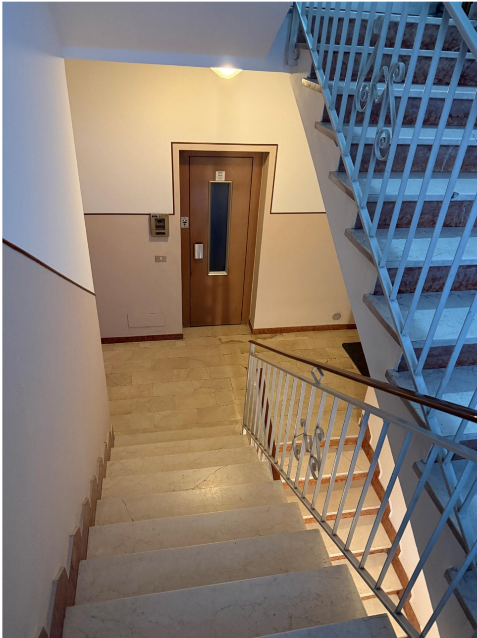
Fotografia 12 – Locali condominiali: vano scala con ascensore
