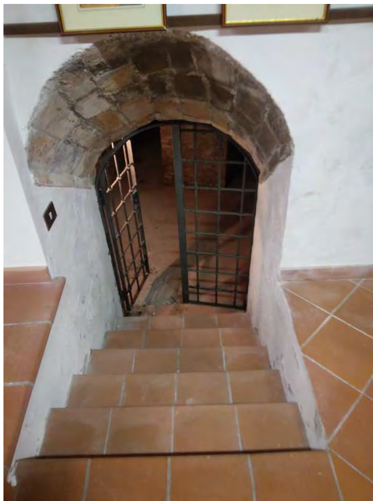
Foto n. 12 – dal grande vano centrale posto nel seminterrato, alcuni gradini conducono ad una porzione ipogea (come in molti edifici del centro storico) non accatastata, né altrimenti documentata
