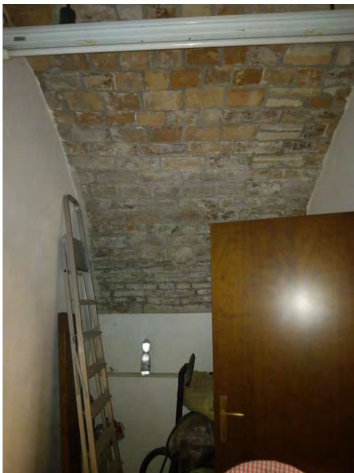
Foto n. 14 – il piccolo vano di servizio ricavato dalla sala centrale mediante la realizzazione di un tramezzo
