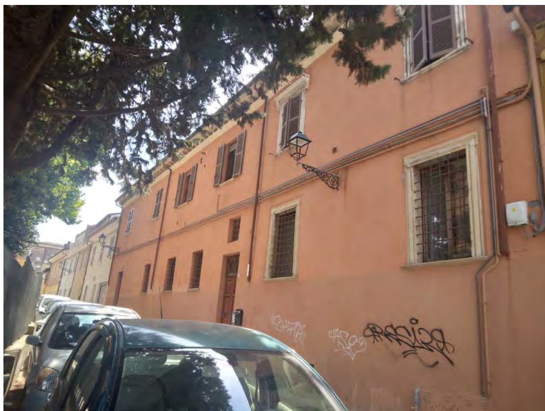
Foto n. 2 – Facciata su via delle Galigarie
