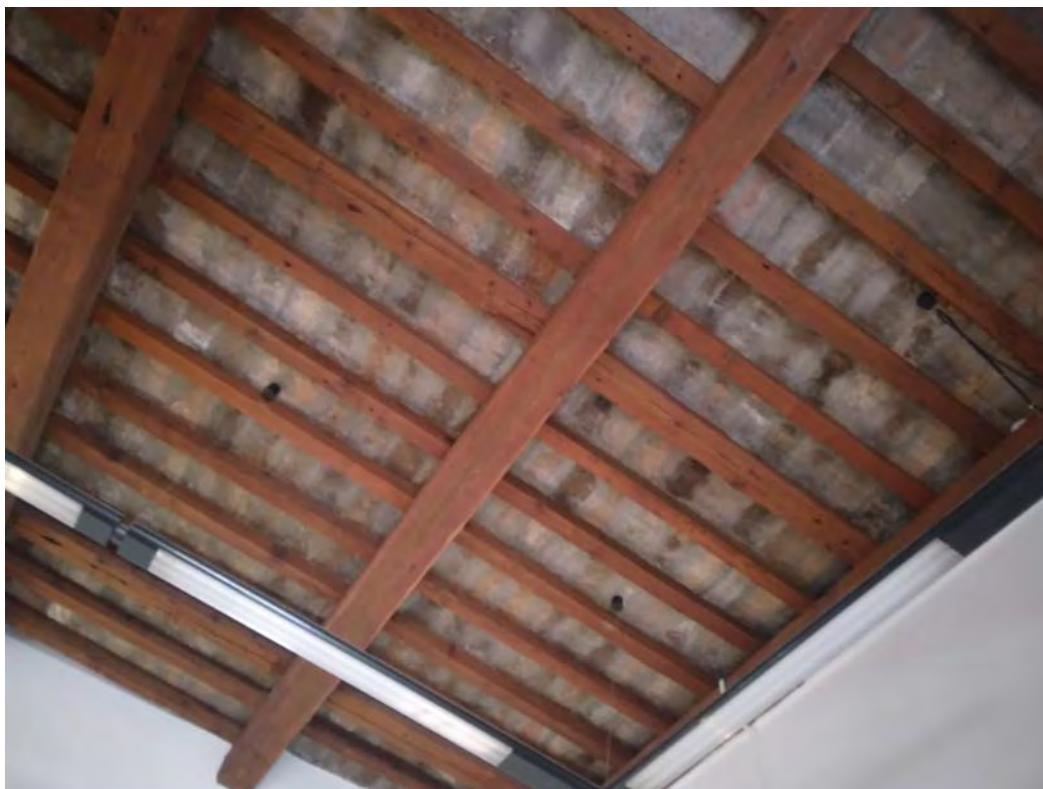
Foto n. 5 – soffitto del vano ingresso in legno e piastrelle di laterizio
