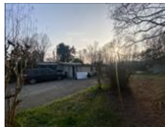
fabbricato non autorizzato
