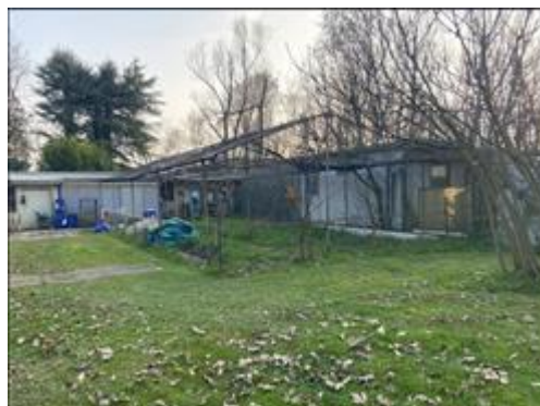
fabbricato non autorizzato
