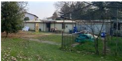
fabbricato non autorizzato
