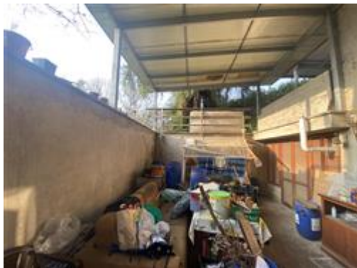
ingresso al piano interrato
