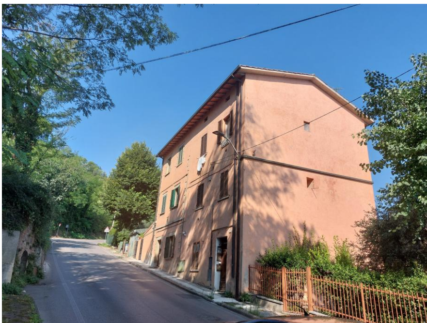
Foto n.3: Particolare dei prospetti sud ed est del fabbricato, ripresi da strada Perugia – Ponte Valleceppi. Notare le pareti esterne intonacate e tinteggiate e i canali di gronda e i pluviali discendenti in lamiera zincata e verniciata.
