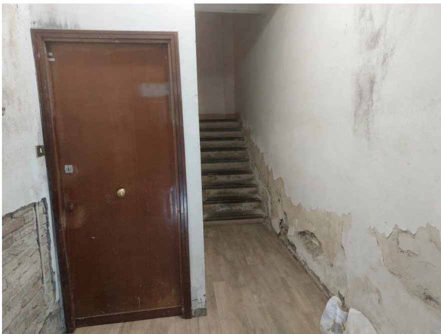
Foto n.5: Particolare del vano scala comune al piano terra. Notare la scala di collegamento tra i piani, il pavimento in travertino e le pareti intonacate e tinteggiate.
