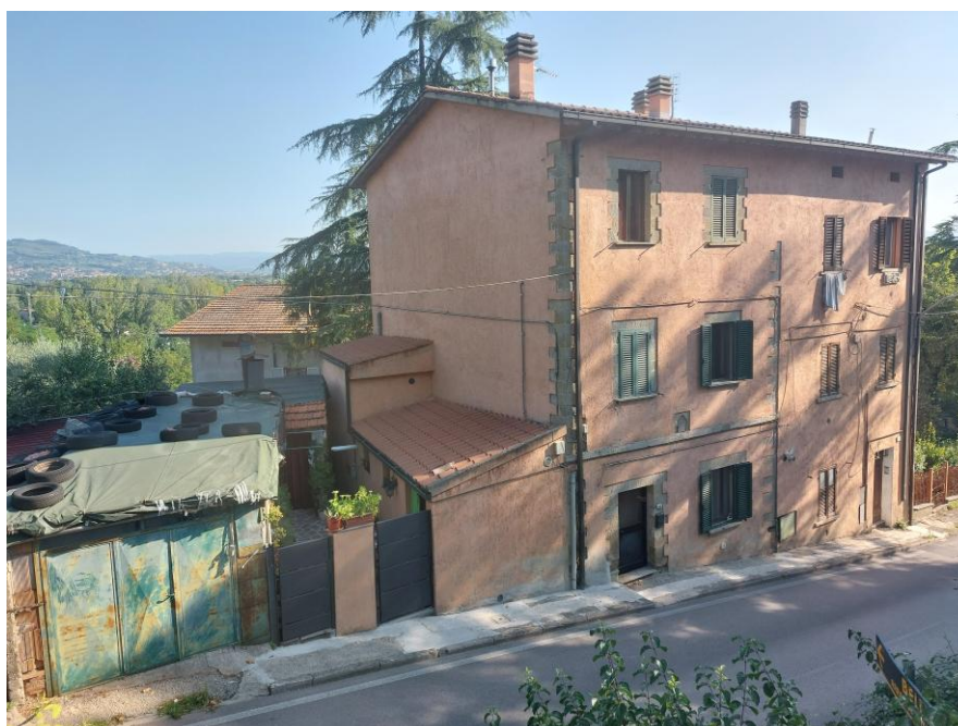
Foto n.2: Particolare dei prospetti sud ed ovest del fabbricato. È visibile, sulla destra dell'immagine, l'ingresso principale al fabbricato al piano terra del bene pignorato. Notare le persiane protettive esterne in legno, il tetto del tipo a due falde e il manto di copertura in coppo tegola.
