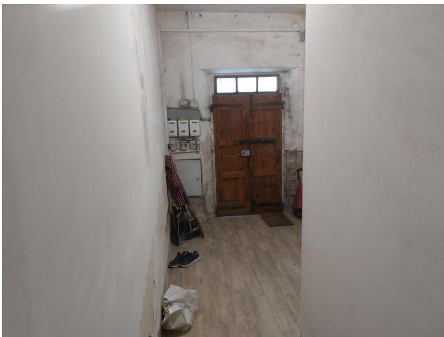
Foto n.6: Altro particolare del vano scala al piano terra, ripreso da angolazione opposta all'immagine precedente. Notare il portone in legno a due ante con sopraluce e i contatori della luce elettrica.
