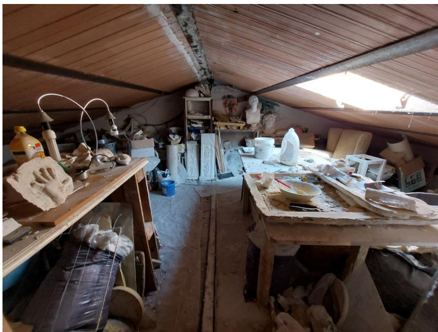
Foto n.18: Altro particolare della soffitta. Notare, il tetto del tipo a due falde e sullo sfondo le pareti intonacate e tinteggiate.
