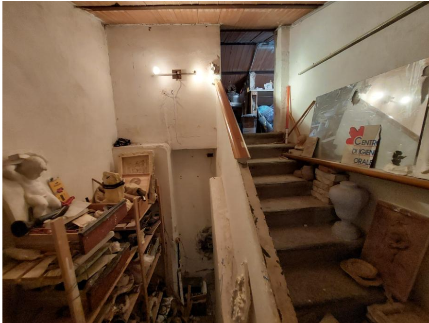
Foto n.15: Particolare della soffitta al terzo piano sottotetto. Notare l'apertura di accesso alla soffitta, la scala interna di collegamento, le pareti intonacate e tinteggiate e l'impianto elettrico sottotraccia.
