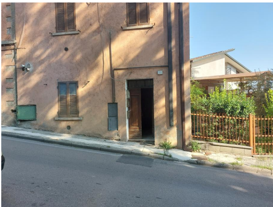
Foto n.4: Particolare dell'ingresso principale al fabbricato al piano terra sul prospetto principale sud (civico n.108). Sono visibili in primo piano, il portone in legno a due ante con sopraluce e gli alloggi dei contatori.
