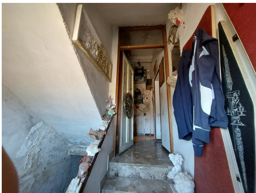
Foto n.8: Particolare dell'ingresso dell'appartamento al secondo piano, ripreso da angolazione opposta all'immagine precedente. Notare, in primo piano, il portoncino in legno con sopraluce che delimita l'accesso e, sullo sfondo, il disimpegno di smistamento.
