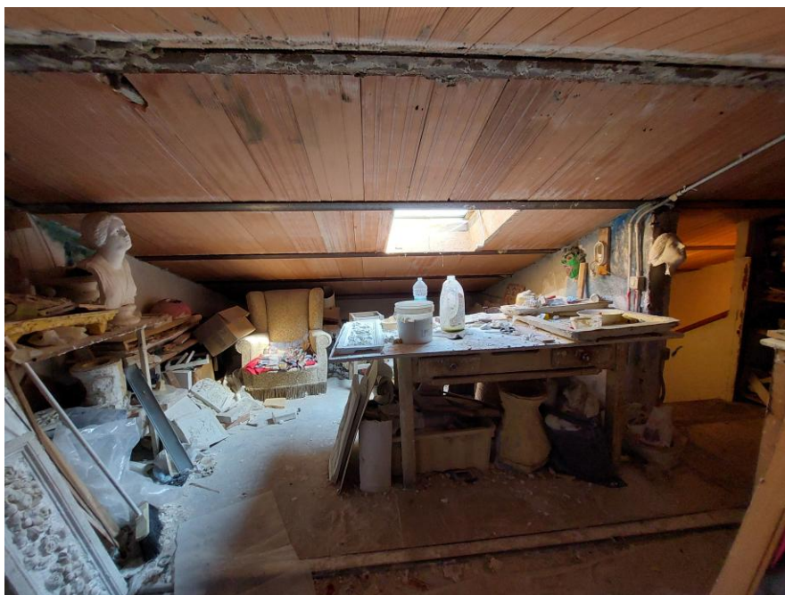
Foto n.17: Altro particolare della soffitta. Notare, il lucernario a solaio, il pavimento in graniglia di marmo e i solai in travi di ferro e tavelloni non intonacati né tinteggiati. È visibile sulla destra dell'immagine, l'accesso alla soffitta.
