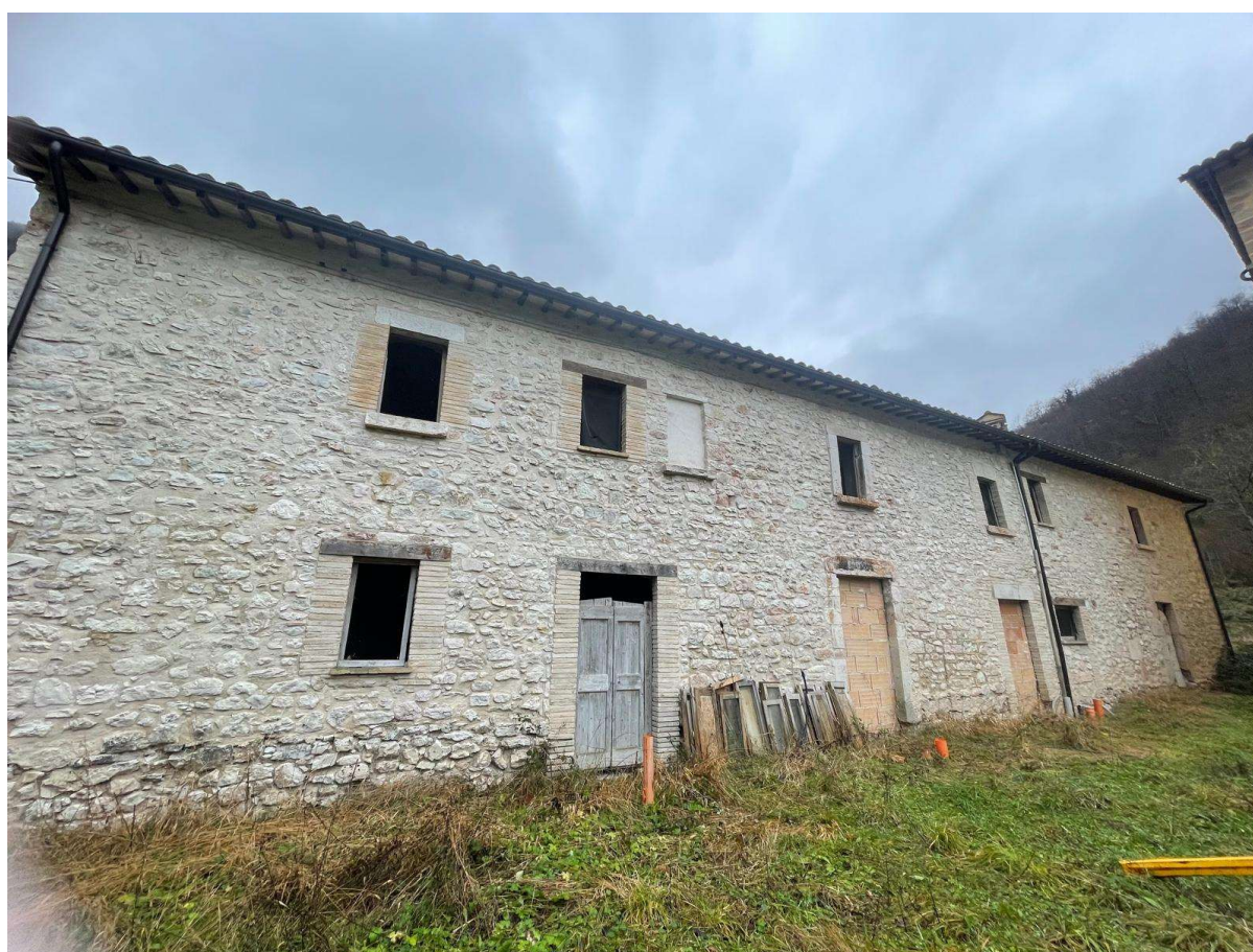
Foto n. 3-4 – Prospetto anteriore ex casa colonica
