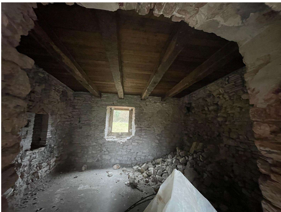
Foto n. 8-11 – Ambienti interni all'ex casa colonica (PT)
