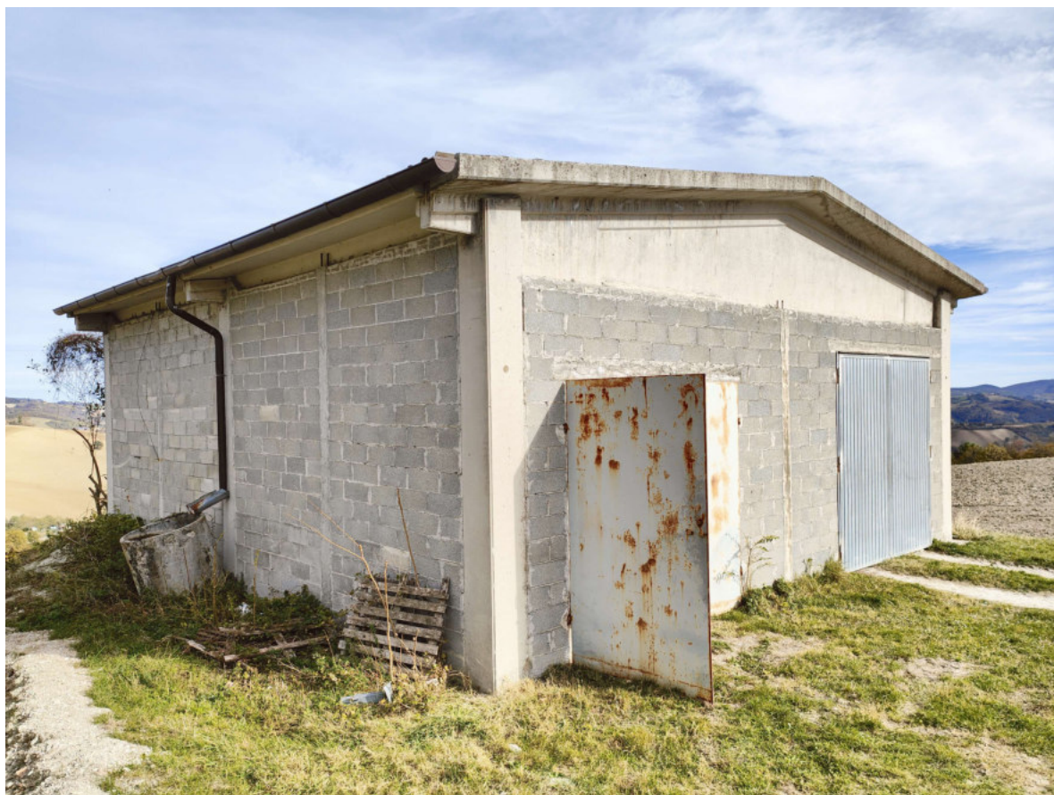
04) Fabbricato per usi agricoli - Fianco sinistro
