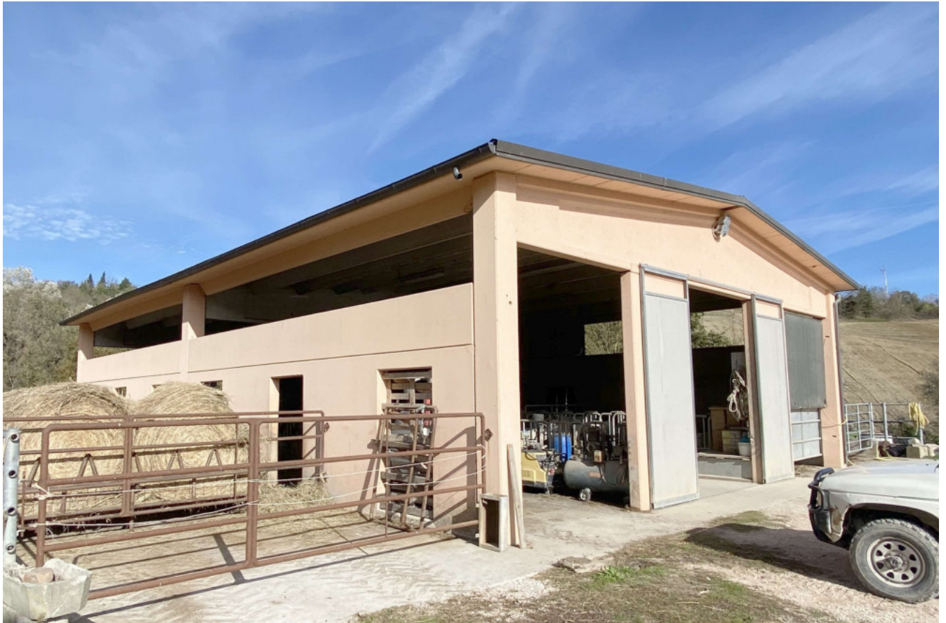
01) Stallone - Fabb. a) Prospetto principale - Fianco sinistro
