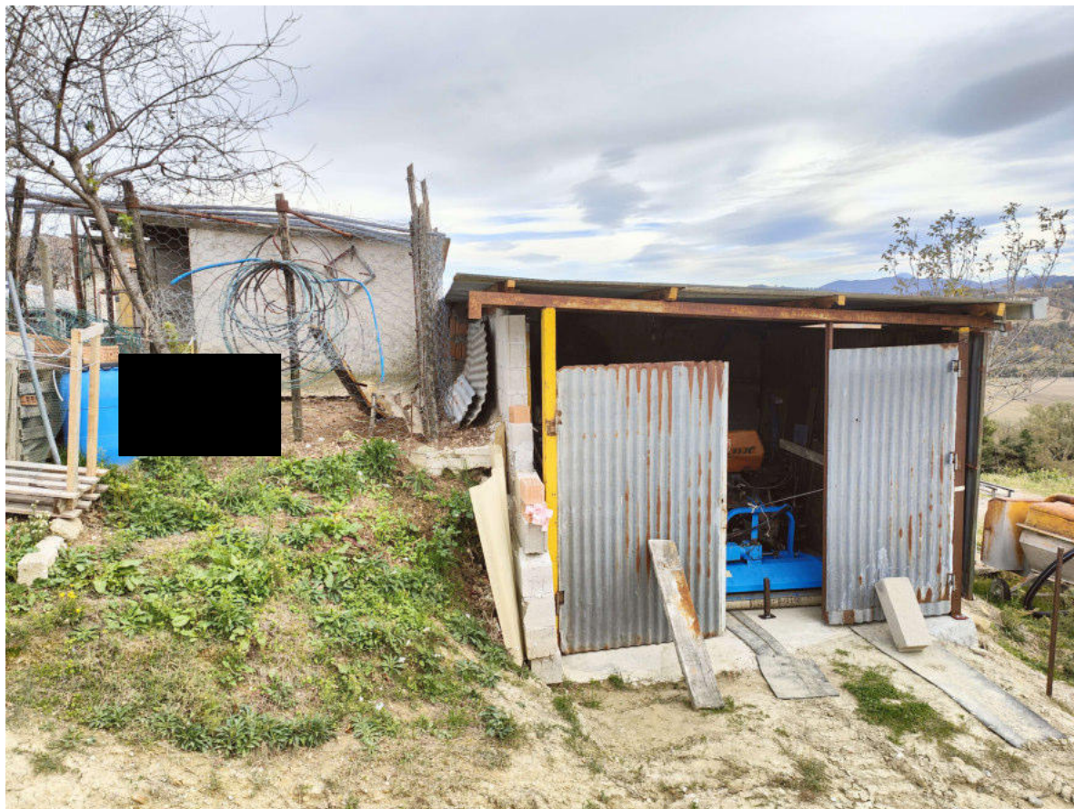
09) Struttura precaria (2) da rimuovere
