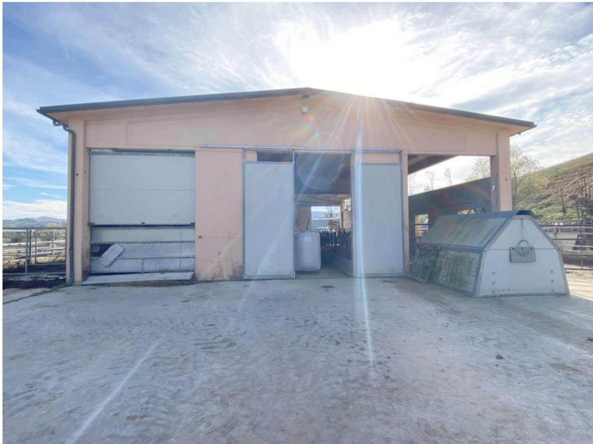
03) Stallone - Fabb. a) Retro - piazzale
