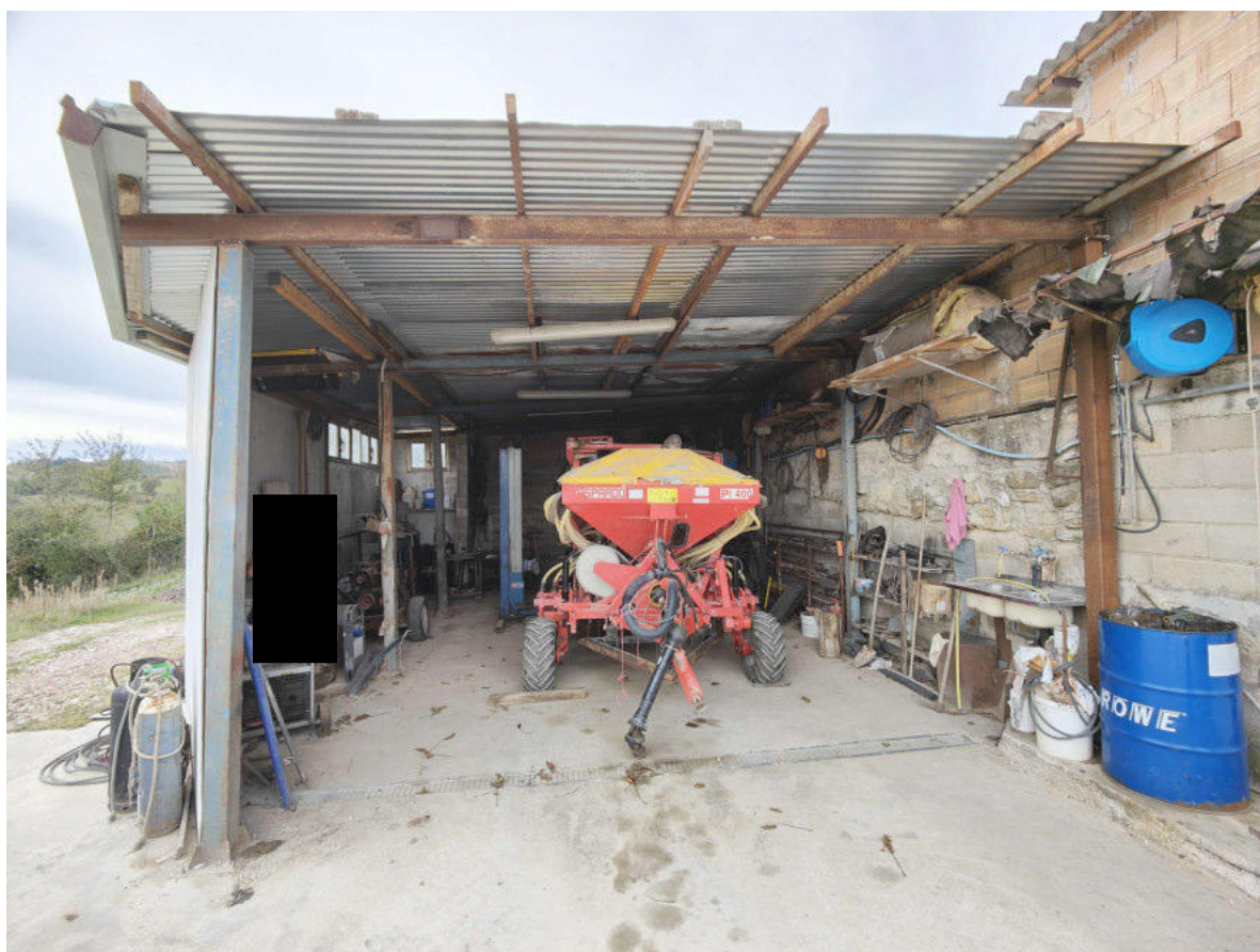
04) Struttura precaria per ricovero attrezzi - dettaglio
