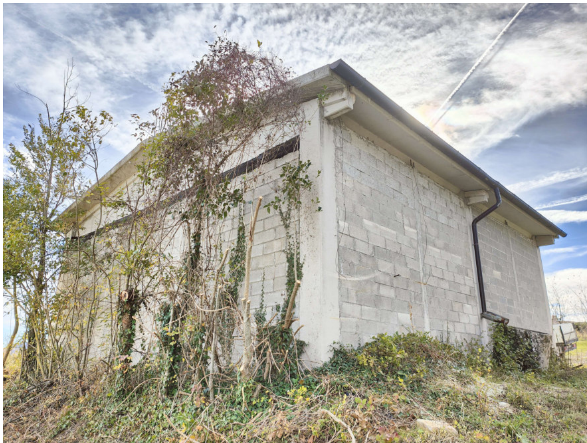
03) Fabbricato per usi agricoli - Retro
