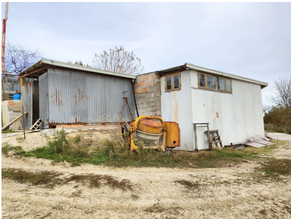
10) Struttura precaria (2-3) da rimuovere
