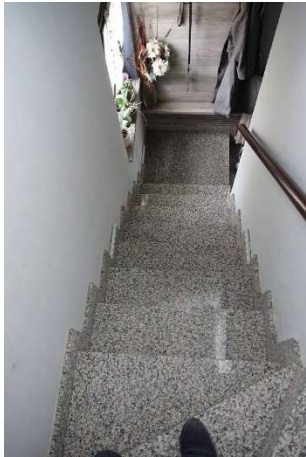
← Fig. 14 – La scala in c.a con pedate e alzate in granito che collega il piano terreno al primo piano
