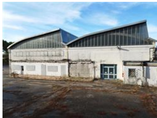
Particolare zona "uffici" demolita
