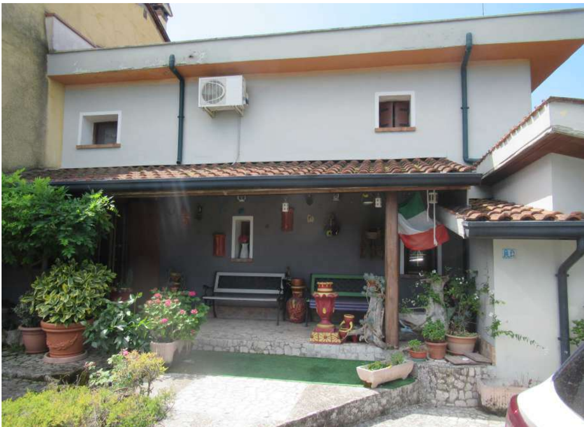
Foto 4: Prospetto Nord abitazione
