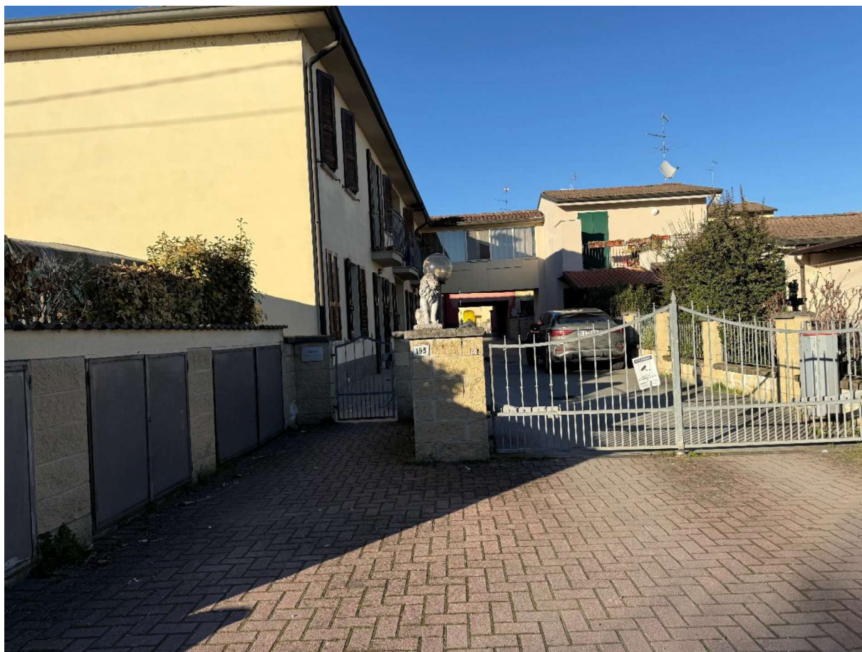
INGRESSO COMPLESSO IMMOBILIARE
