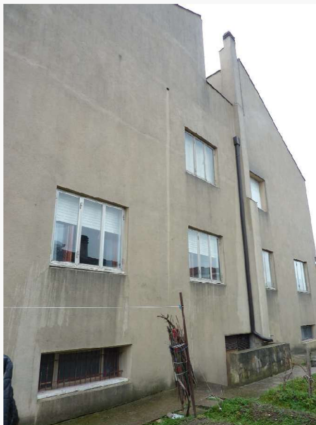
FOTO 6 _ DETTAGLIO RETRO DEL FABBRICATO DALL'AREA PERTINENZIALE ESTERNA – PROSPETTO EST
