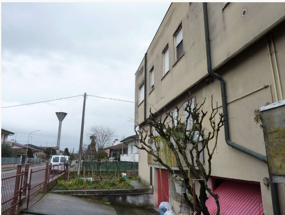
FOTO 9 _ VISTA LATERALE DEL FABBRICATO DALL'AREA PERTINENZIALE ESTERNA – PROSPETTO NORD
