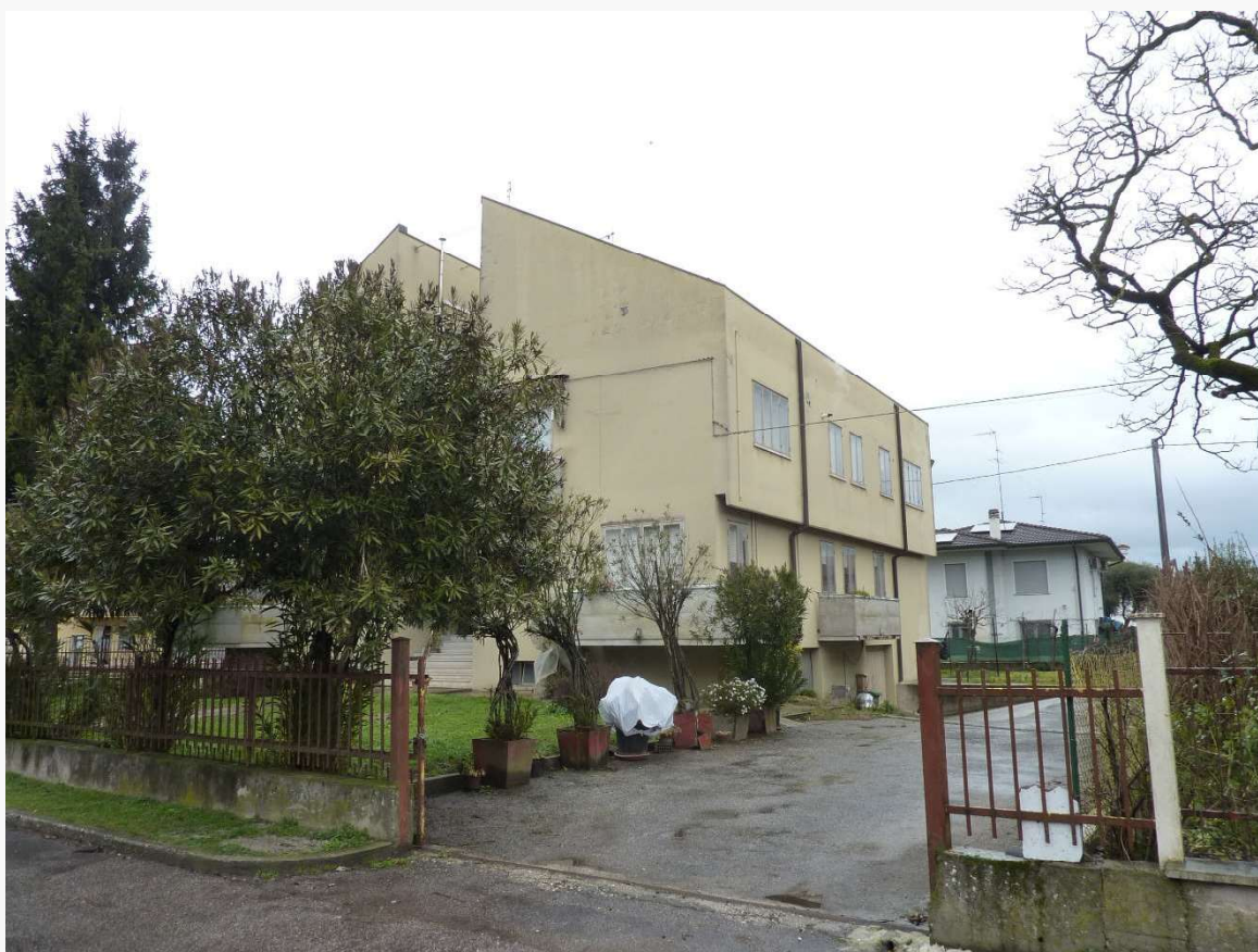
FOTO 13 _ VISTA ANGOLARE DEL COMPLESSO IMMOBILIARE DA VIA BERSAI – PROSPETTI SUD ED OVEST
