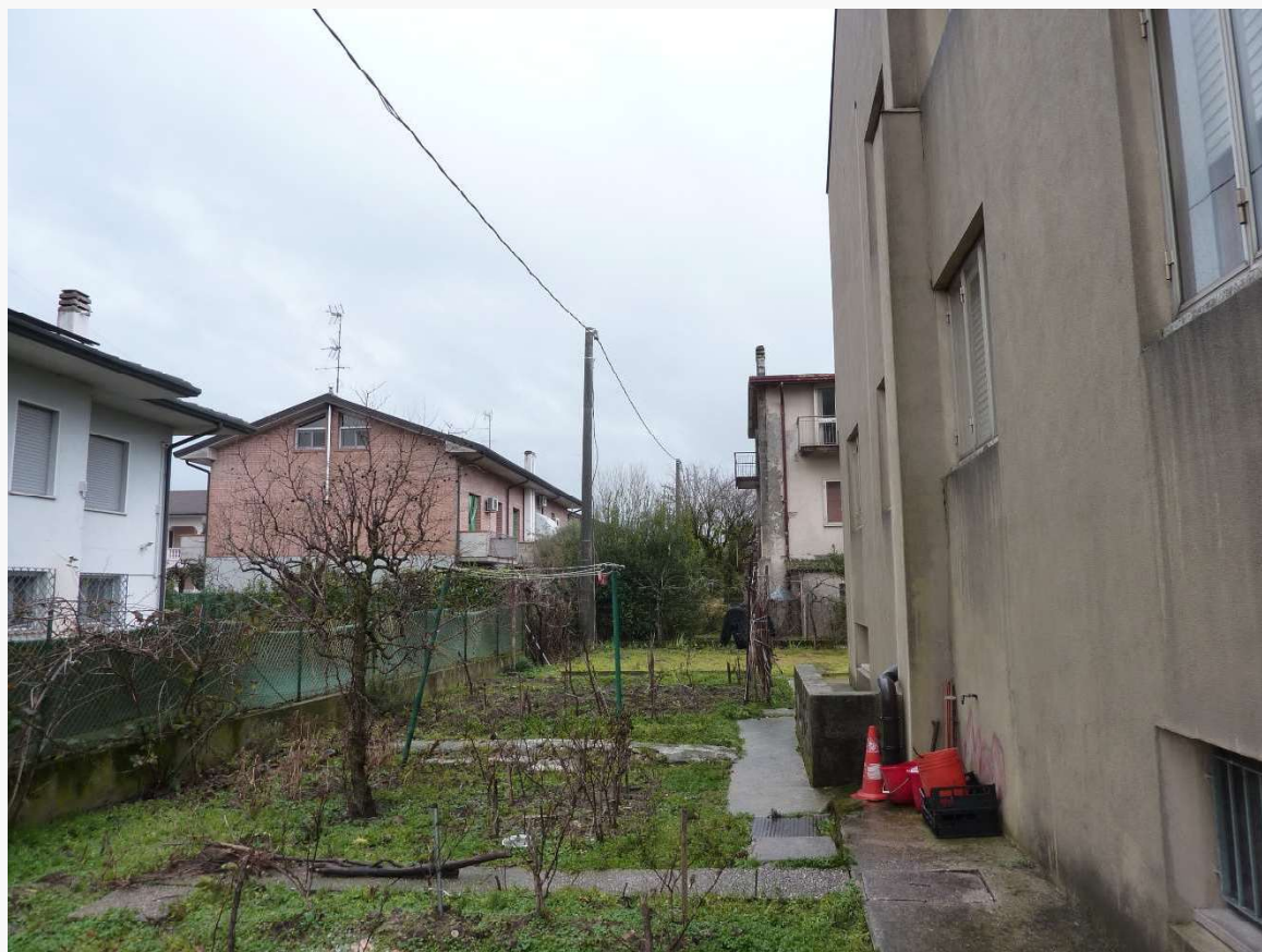
FOTO 8 _ DETTAGLIO RETRO DEL FABBRICATO DALL'AREA PERTINENZIALE ESTERNA – PROSPETTO EST
