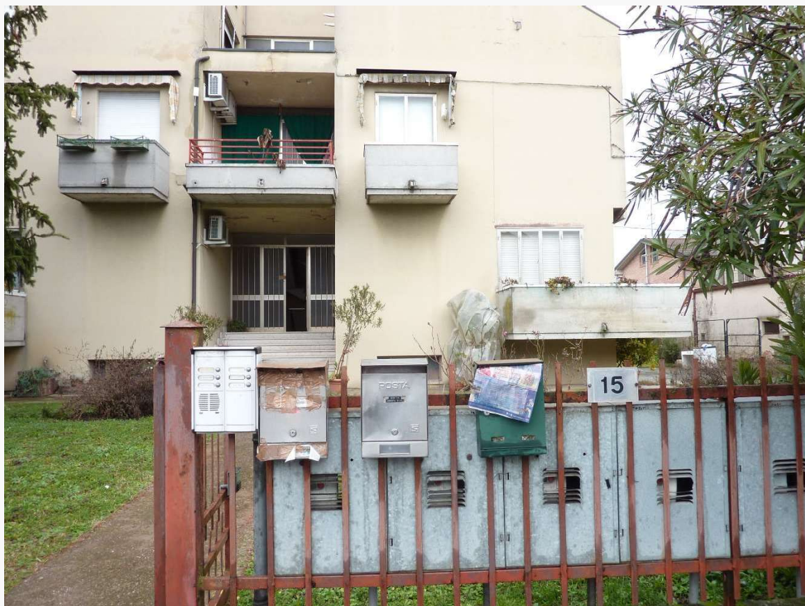
FOTO 14 _ DETTAGLIO ACCESSO AL FABBRICATO DA VIA BERSAI – PROSPETTO OVEST
