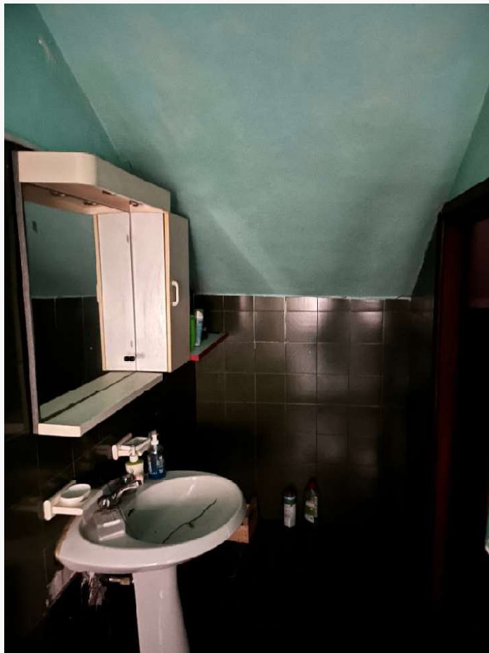
FOTO 10 _ VISTA INTERNA – BAGNO APPARTAMENTO SUB 6 – PIANO SECONDO
