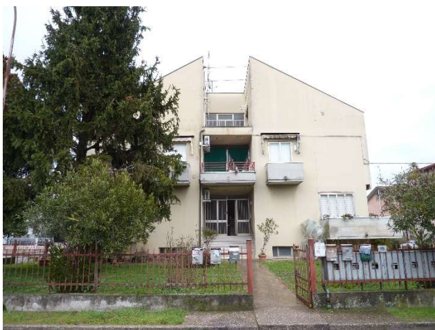
Viste fronte del fabbricato.
