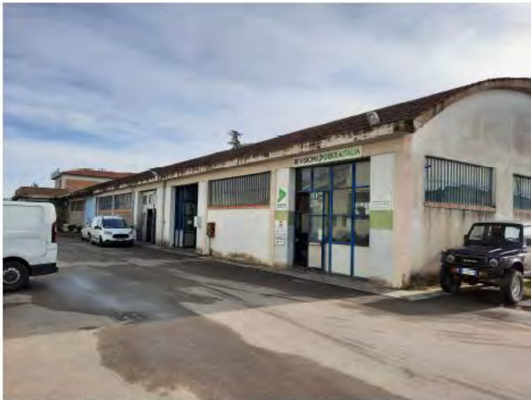
Foto n°6 – Blocco B - lato nord
