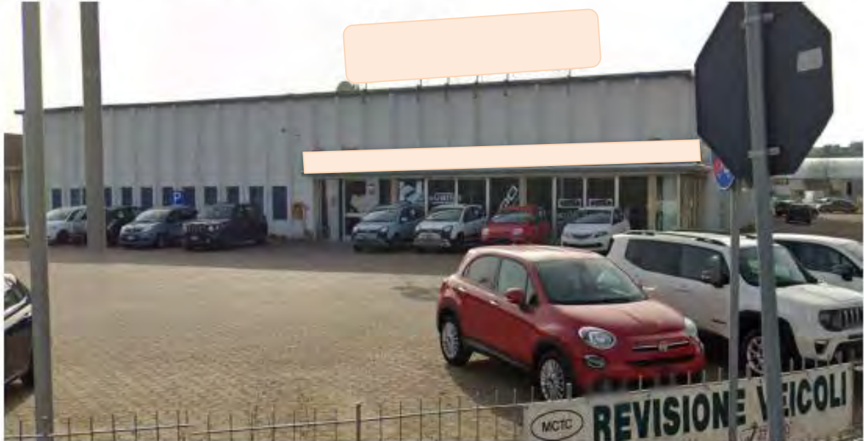
Foto n°1 – Fronte Blocco A
