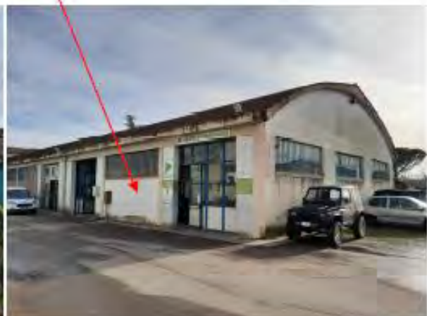
Foto n. 5 : Fabbricato "B", veduta d'angolo del fronte fabbricato con indicata la parete da demolire
