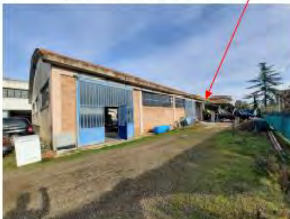
Foto n. 5 : Fabbricato "B", veduta d'angolo comprendente il lato destro ed il retro fabbricato con indicato la porta da tamponare
