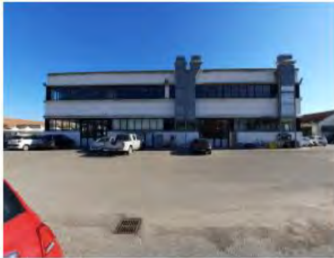
Foto n°4: Fabbricato "A", fronte sud
