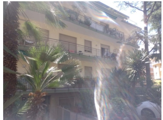
Foto 2_ vista fronte principale
