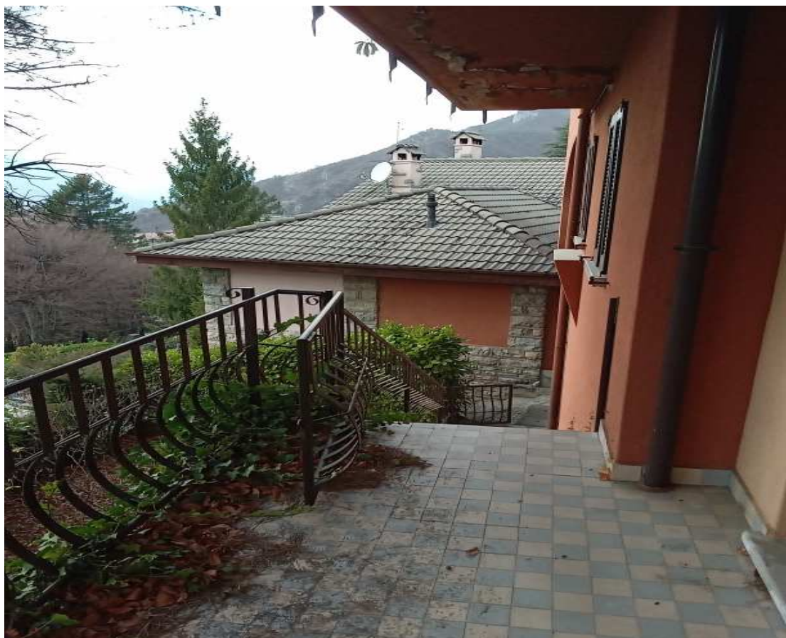
FOTO ESTERNO DI ACCESSO AL SUB 3
