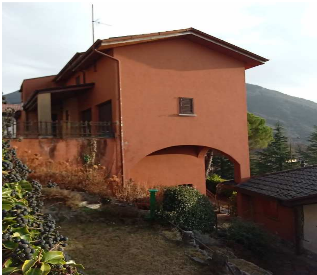
FOTO ESTERNO FRONTE OVEST
