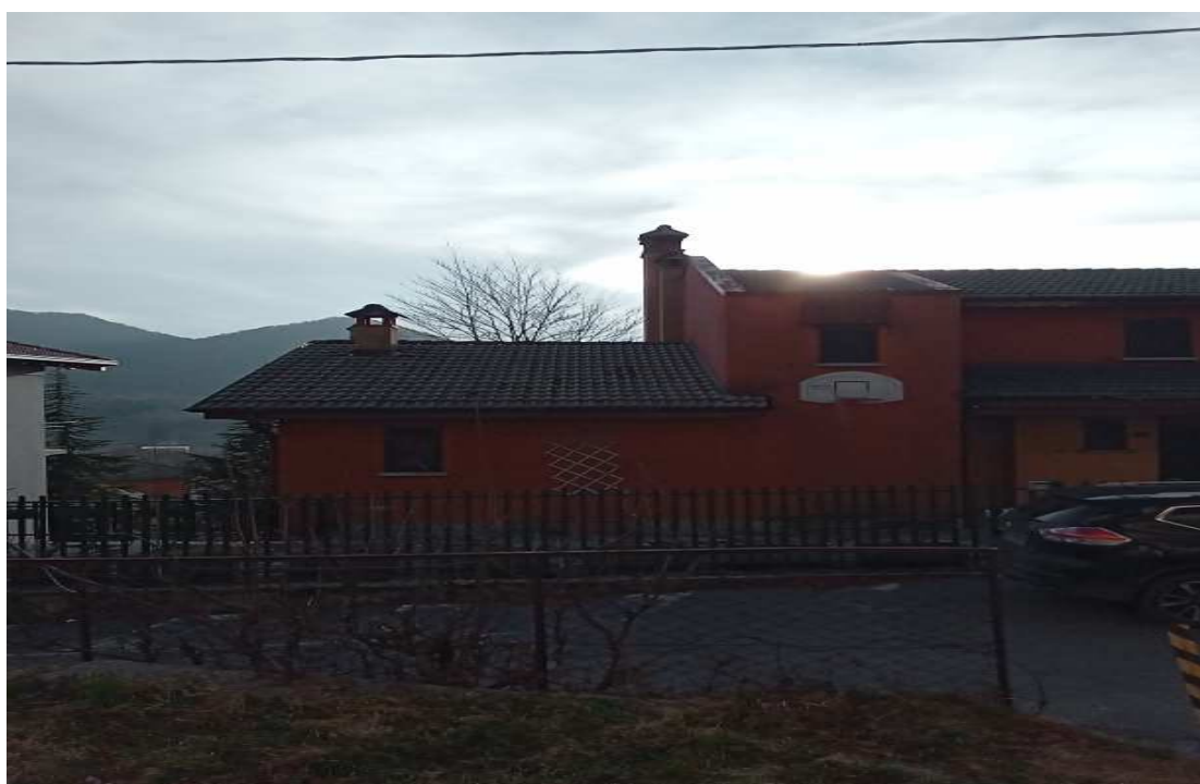
FOTO ESTERNO FRONTE NORD
