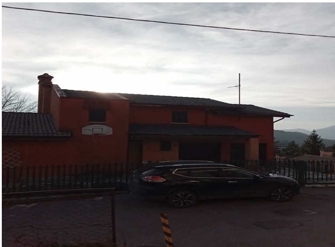
FOTO ESTERNO FRONTE NORD
