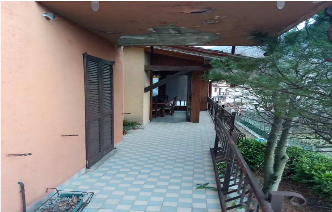
FOTO BALCONATA SUB.4 LATO SUD
