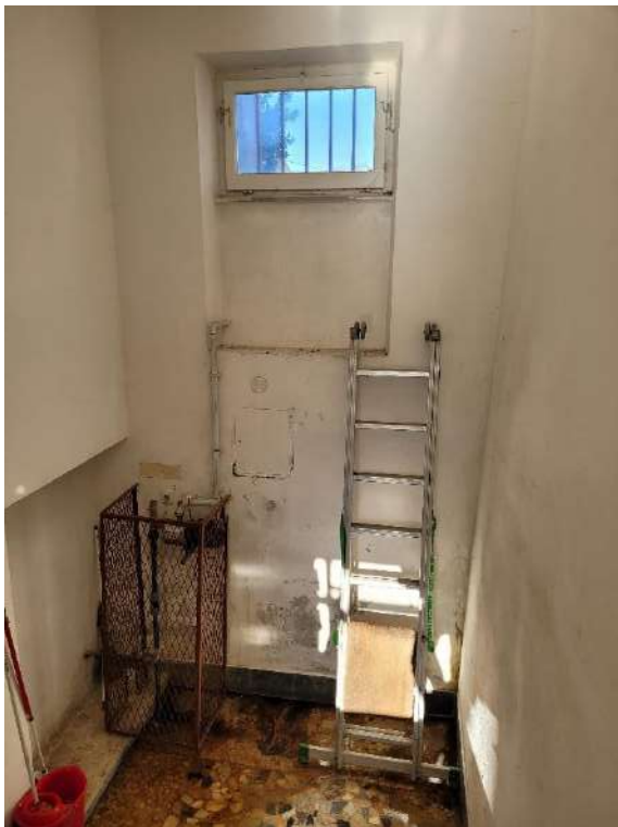
Foto 13- Accesso alle cantine
