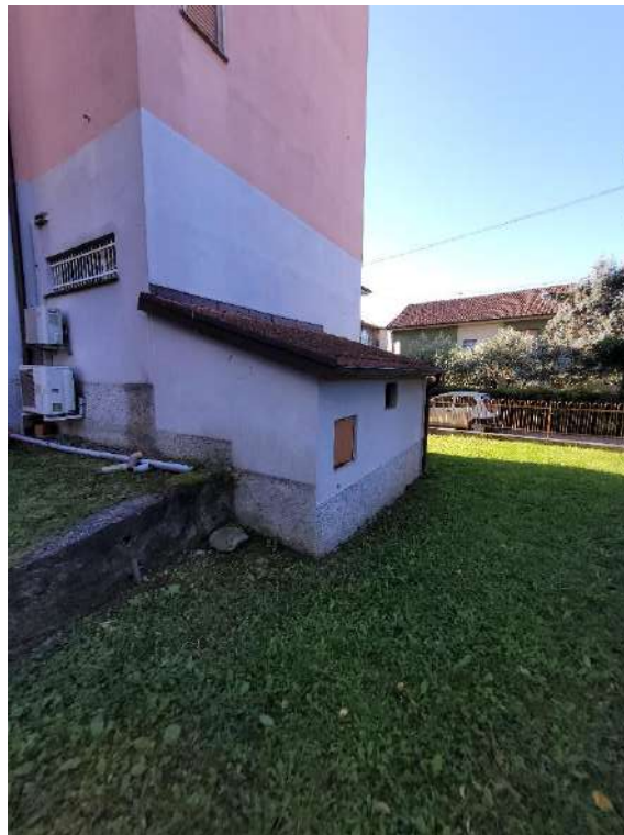
Foto 16- Locale tecnico esterno (non indicato nei progetti)
