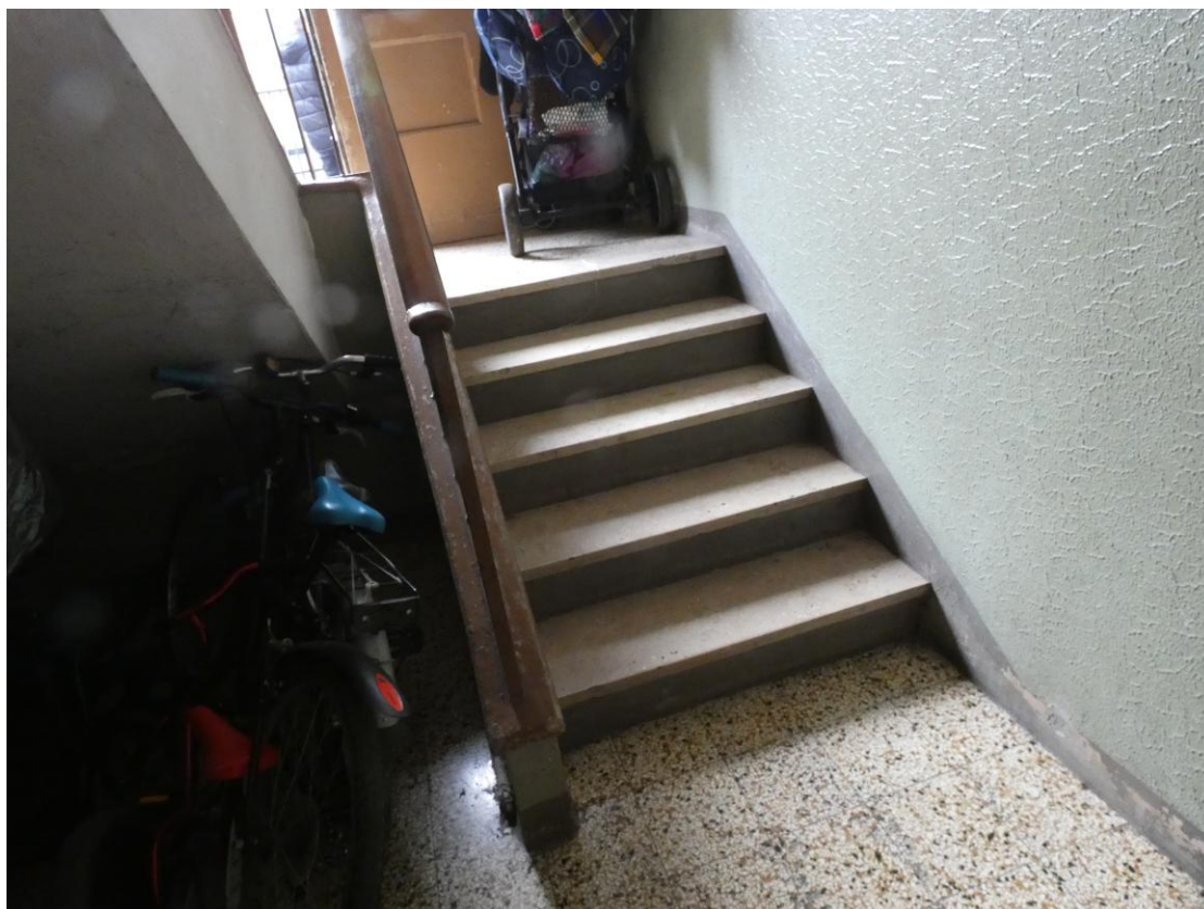
Presa fotografica 06 – Vista Interna: rampa d'accesso al Piano Seminterrato
