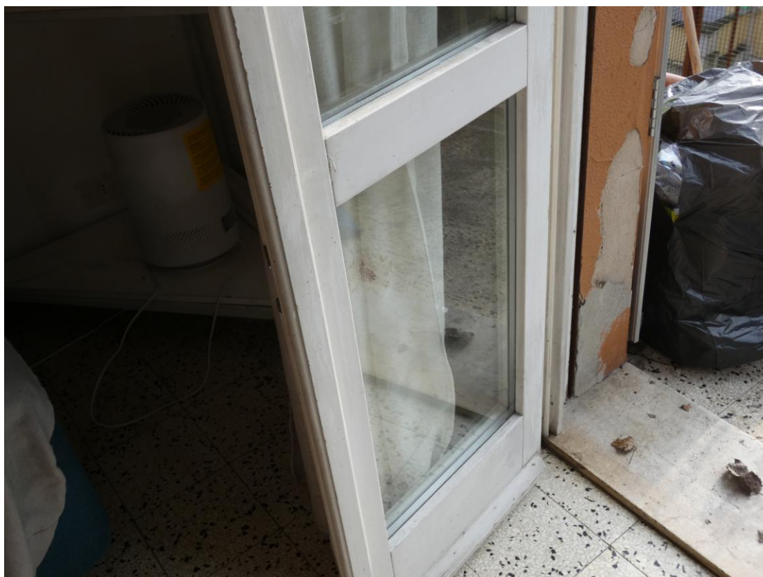
Presa fotografica 25 – Vista Interna: dettaglio porta finestra sul balcone
