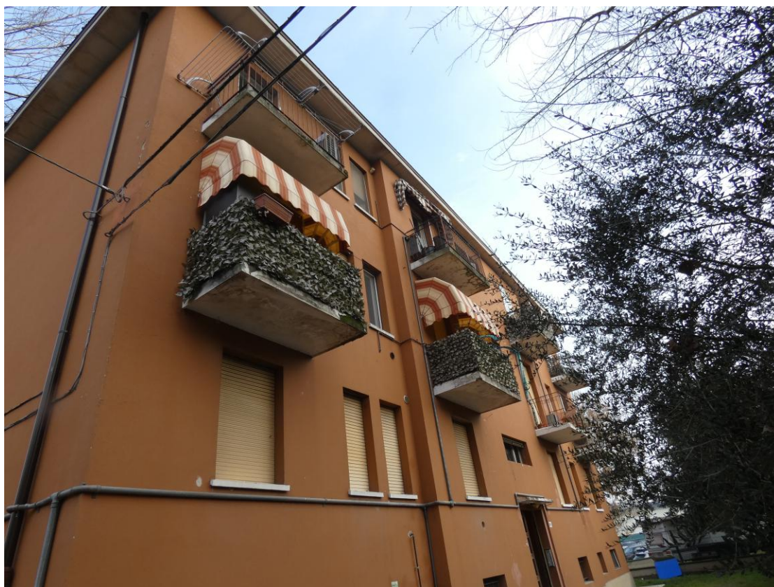
Presa fotografica 03 – Vista Esterna: prospetto Sud
