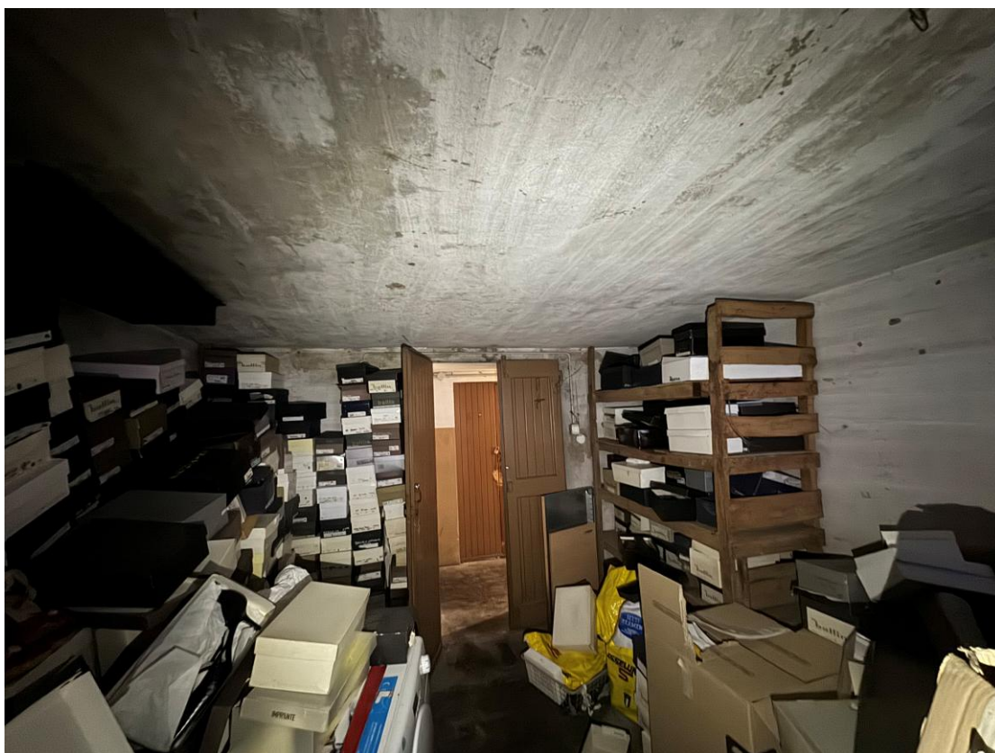
Presa fotografica 12 – Vista Interna: Cantina
