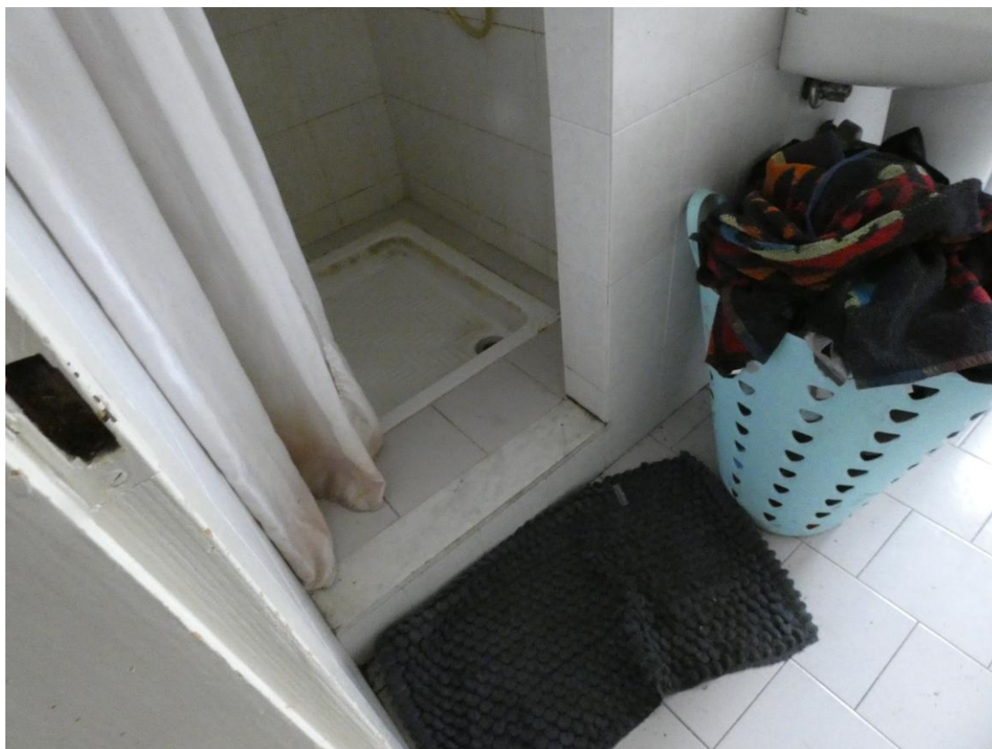
Presa fotografica 38 – Vista Interna: Bagno, dettaglio doccia
