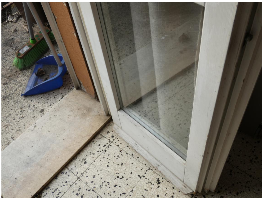
Presa fotografica 26 – Vista Interna: dettaglio porta finestra sul balcone
