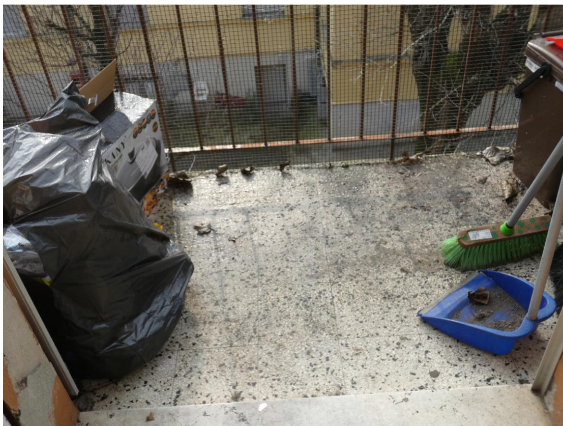
Presa fotografica 27 – Vista Interna: dettaglio pavimentazione balcone
