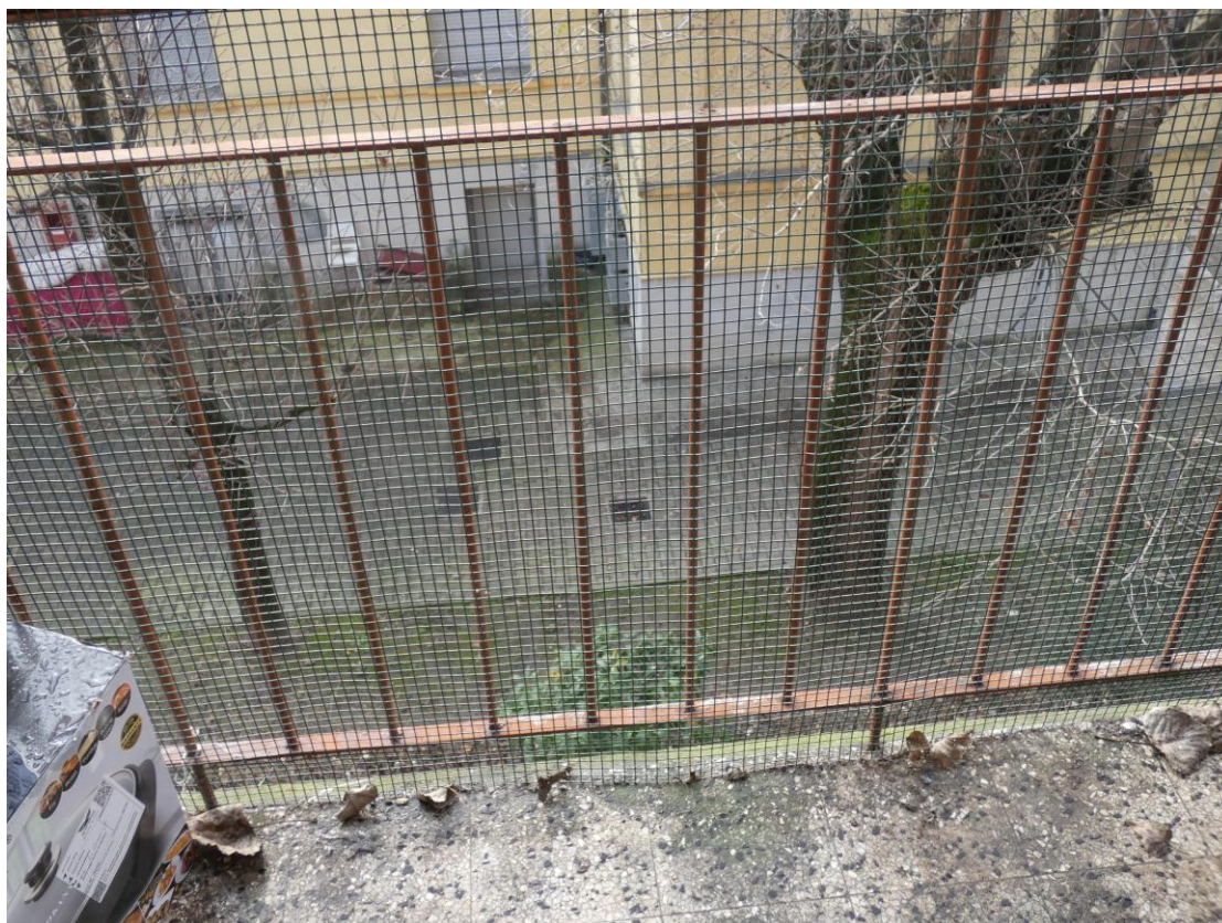
Presa fotografica 28 – Vista Interna: dettaglio parapetto balcone
