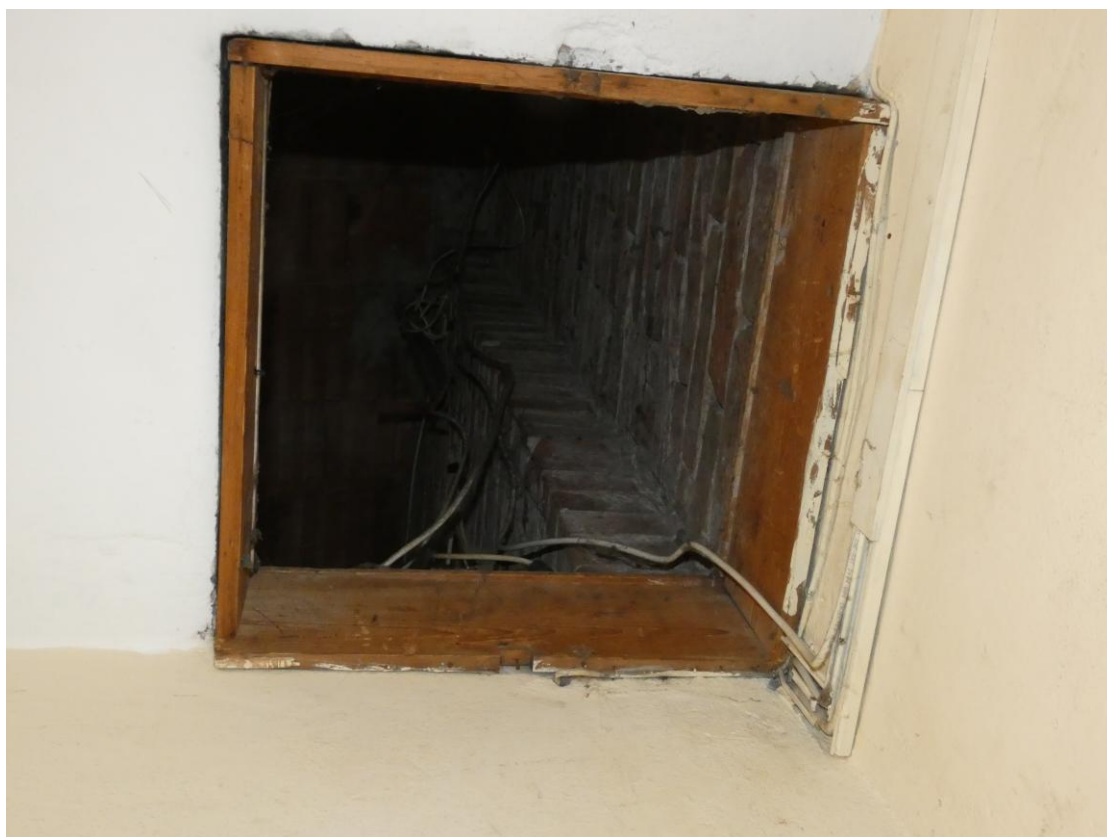
Presafotografica 17 – Vista Interna: Ingresso Sottotetto a cui si accede dal pianerottolo del vano scale
