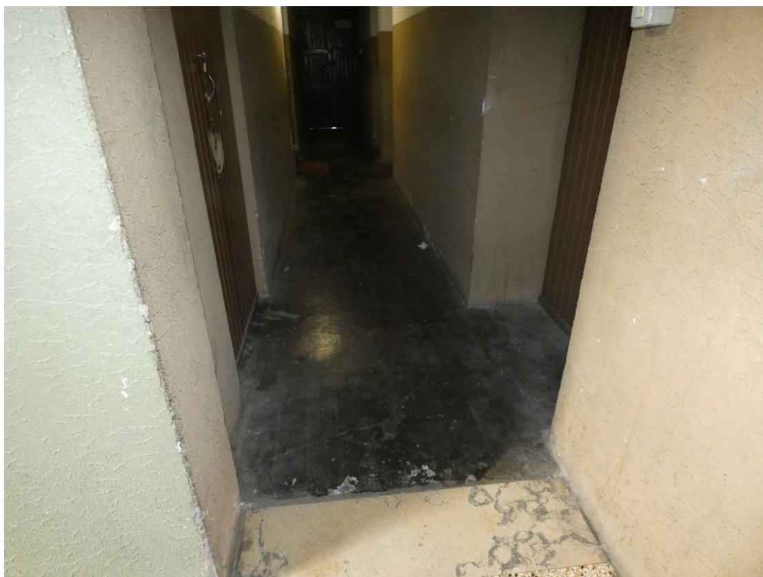
Presa fotografica 07 – Vista Interna: Ingresso zona cantine
