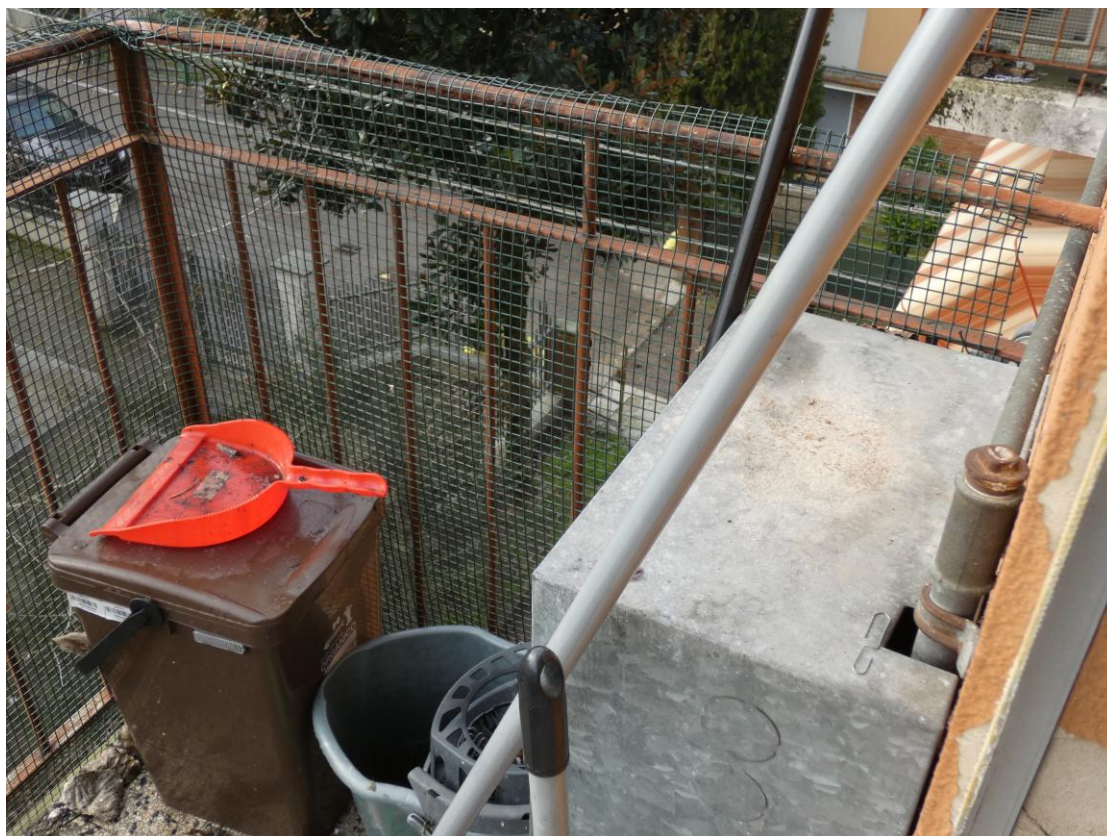
Presenza fotografica 30 – Vista Interna: dettaglio parapetto balcone
