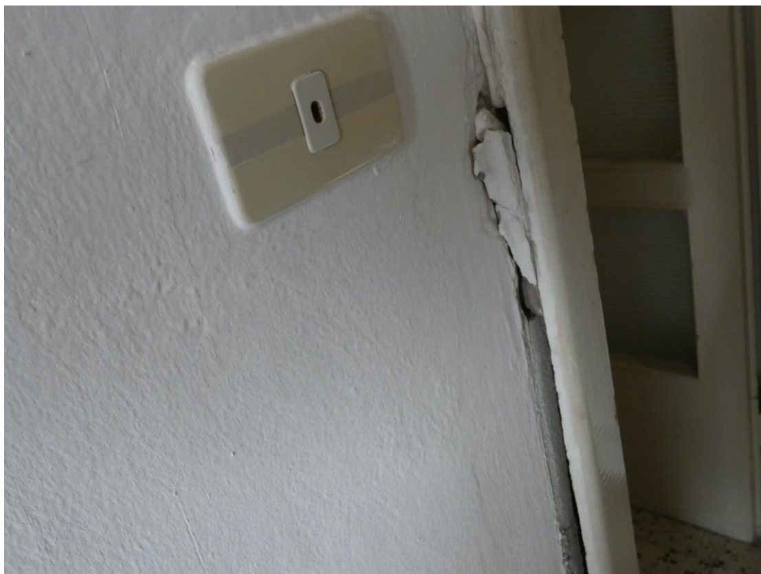
Presa fotografica 56: Dettaglio distacco della cornice della porta nel Soggiorno
