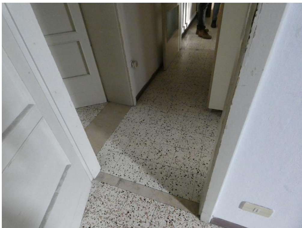
Presenza fotografica 44 – Vista Interna da Camera Letto 1 a Disimpegno Zona Notte
