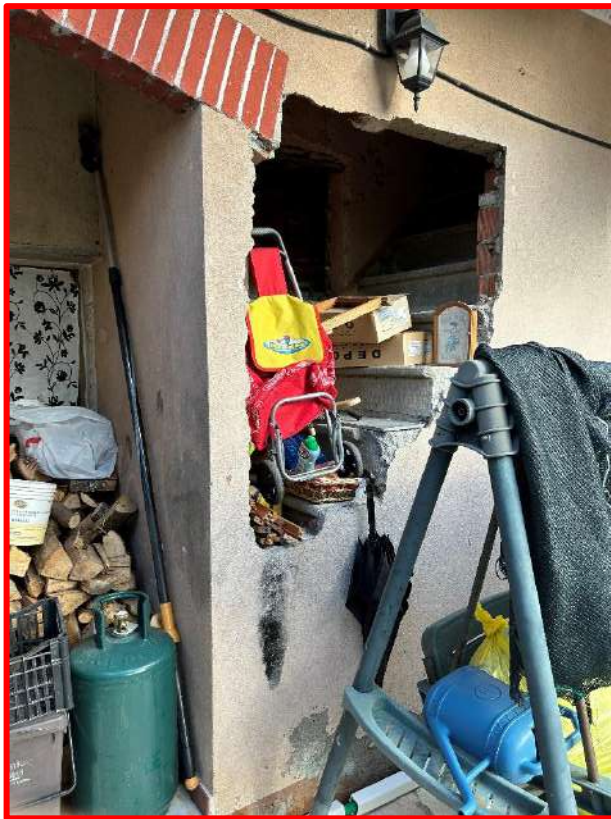
Scala di accesso al piano primo tamponata
