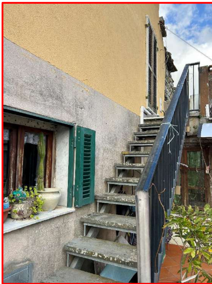
Accesso esterno al Piano secondo dal lastrico del piano primo
