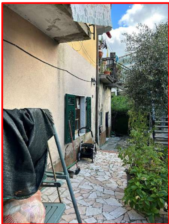
Vista del fabbricato dall'esterno
