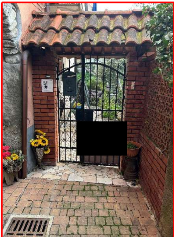
Cancello di ingresso costruito su proprietà comunale
