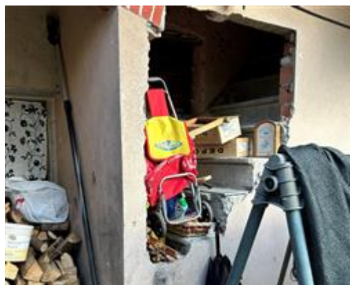
scala preesistente di accesso al piano primo
